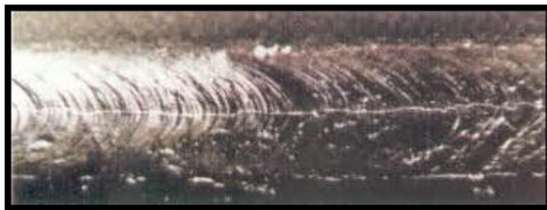
Figura 50 Grieta en la soldadura
