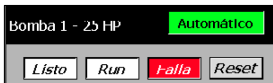
FIGURA 3.85: Electrobomba en estado: Falla
