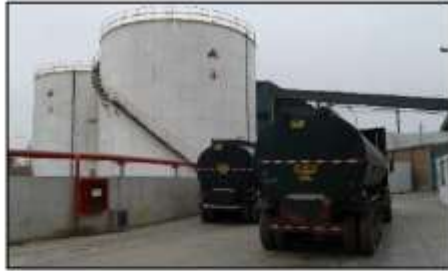
VISTA DE CISTERNAS
