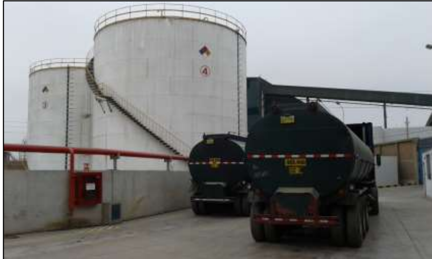
FIGURA 2.12: Tanques y cisternas del proceso
