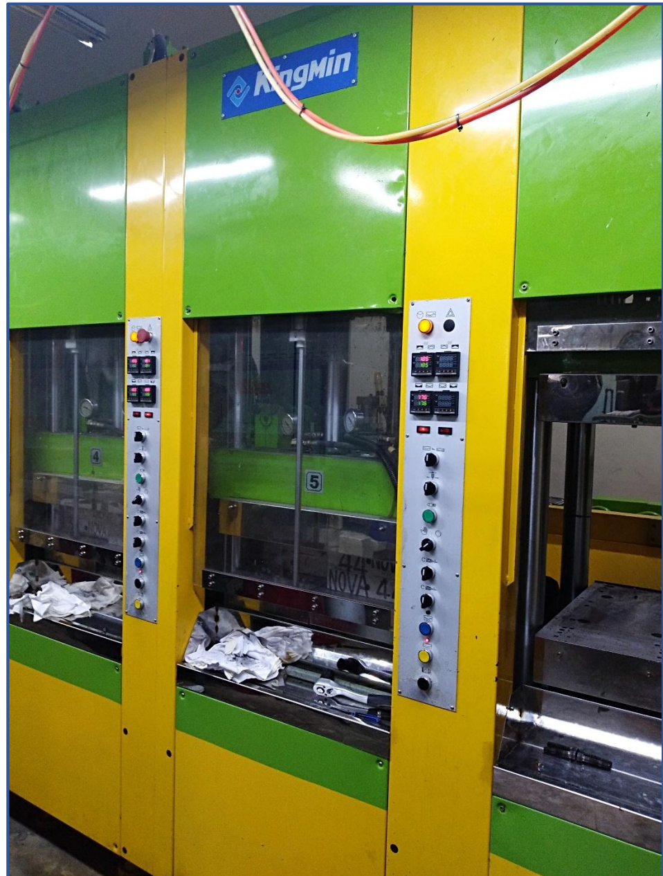
FIGURA 18: Mantenimiento y calibración de compuerta
