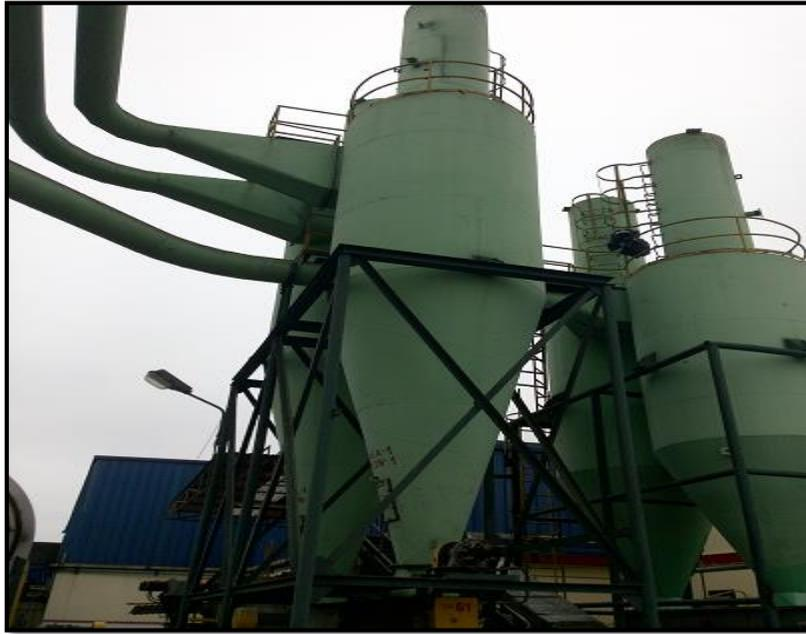
**Sistema de enfriamiento neumático - ciclón del secador de aire caliente N°2**
