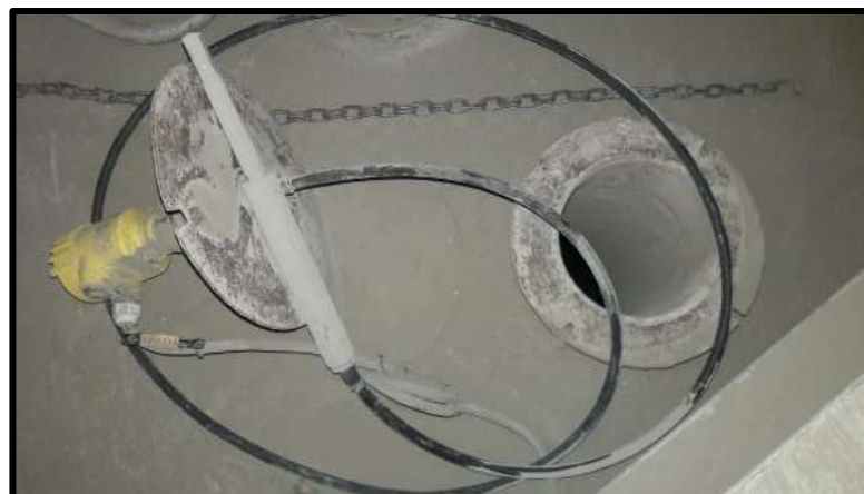
Figura 32. Recubrimiento del material en la horquilla de la sonda
