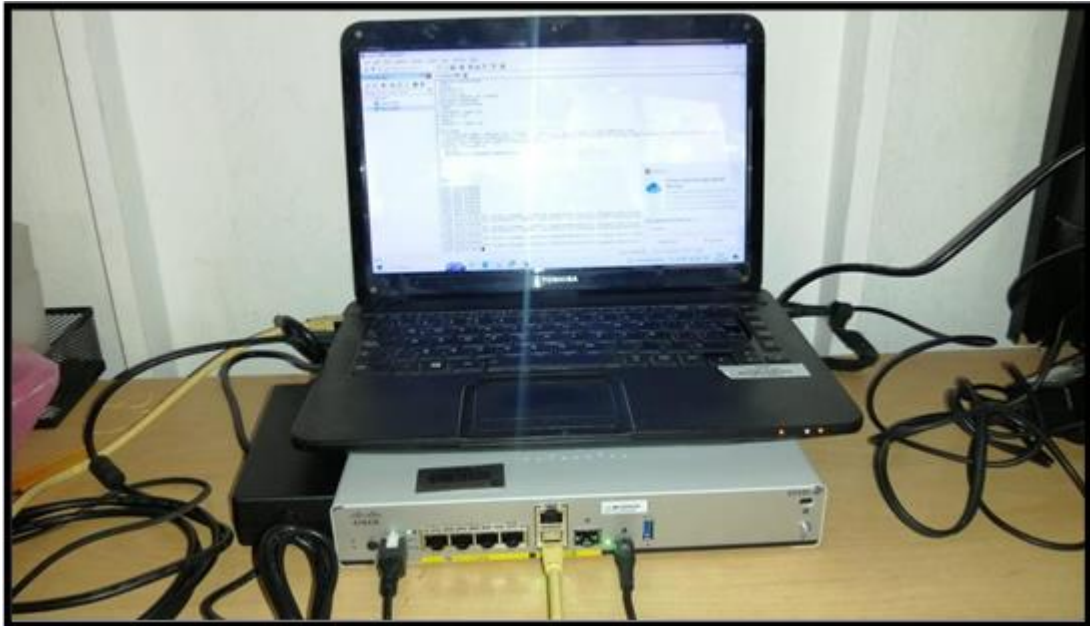
Figura 43 Instalación de los equipos Router
