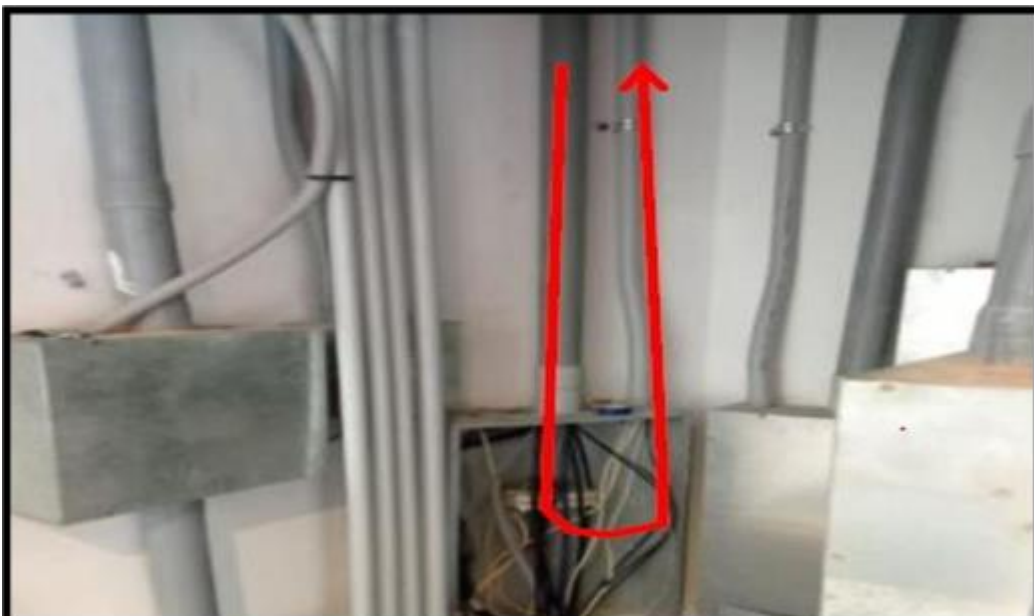
Figura 25 Instalación de la fibra drop.
