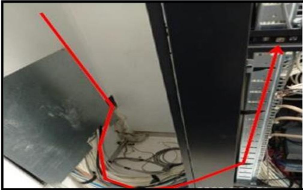
Figura 28 Instalación de la fibra drop.
