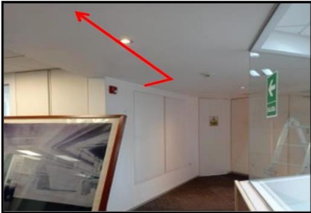
Figura 26 Instalación de la fibra drop.
