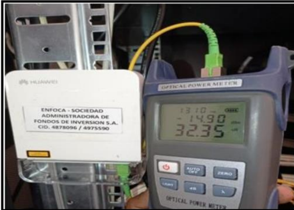
Figura 30 Medición de la roseta instalada
