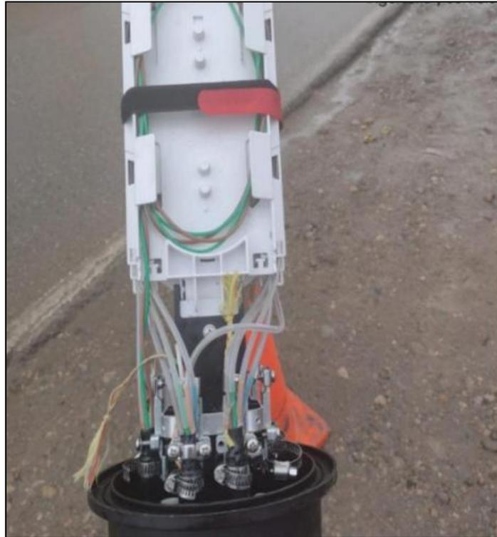
*Figura 32.* Protección de la fusión de fibra
