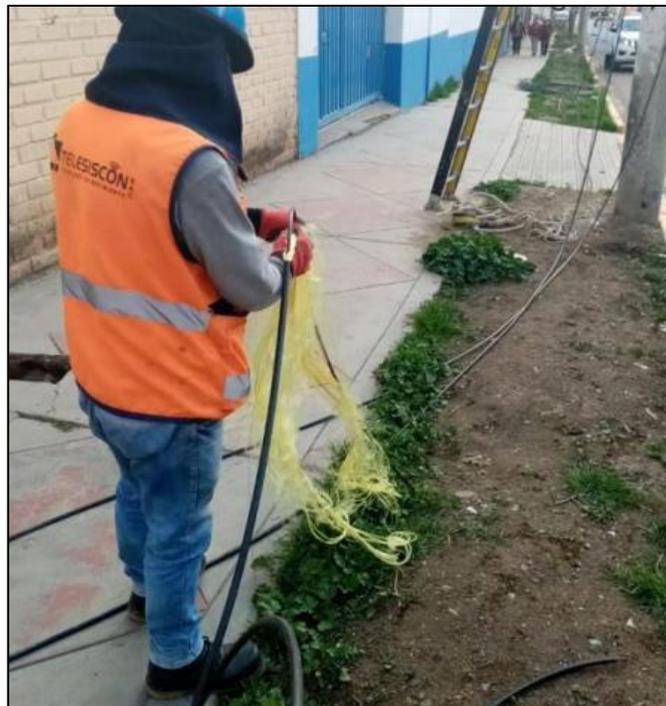
*Figura 30.* Preparación de la fibra oscura
