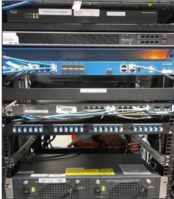
*Figura 40.* ODF instalado en el data center del centro de respaldo
