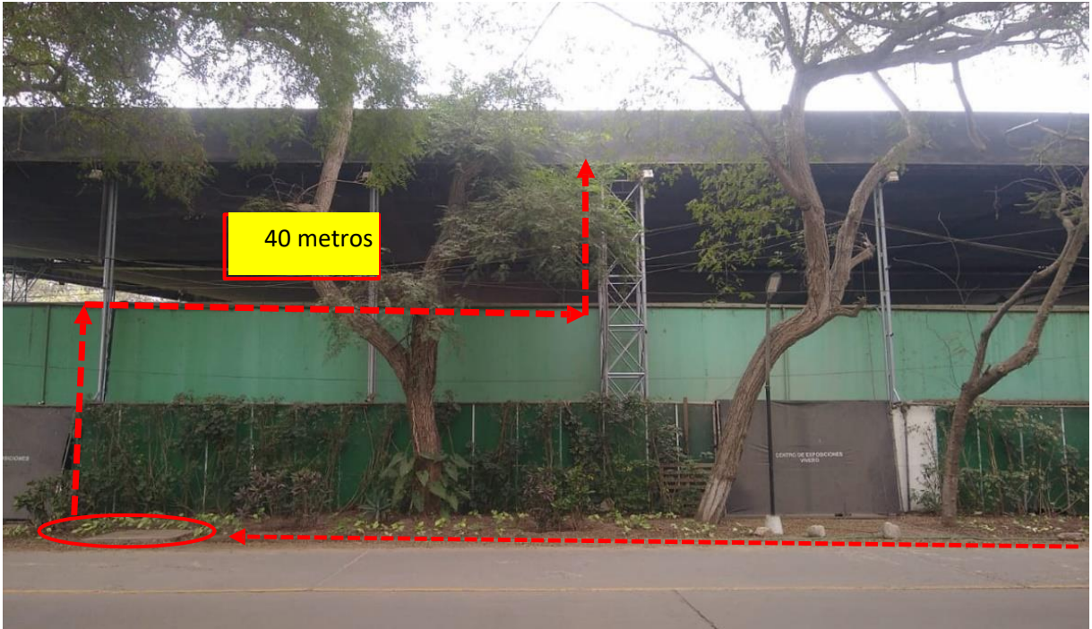
Figura 10. Segundo 2 tramo del recorrido de la fibra óptica
