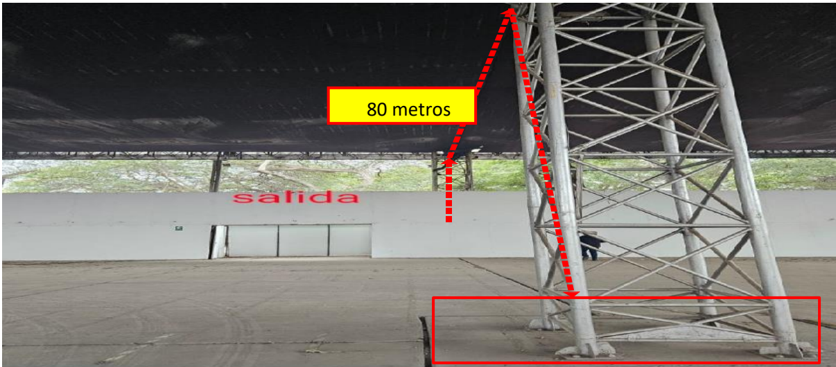
Figura 11. Tercer tramo del recorrido de la fibra óptica
