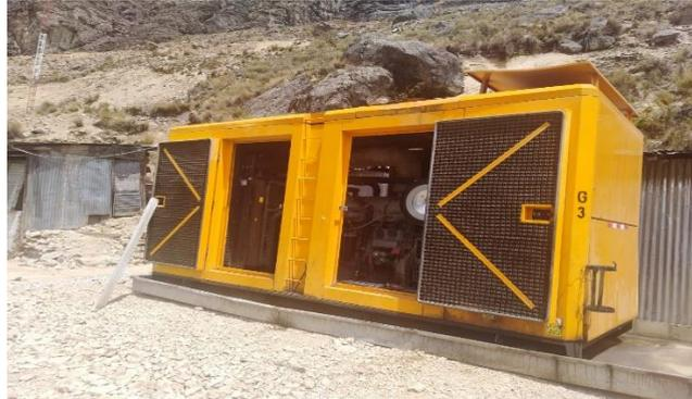
Grupo electrógeno abiertos: requieren de una caseta especial para su operación (ver Figura 4).
