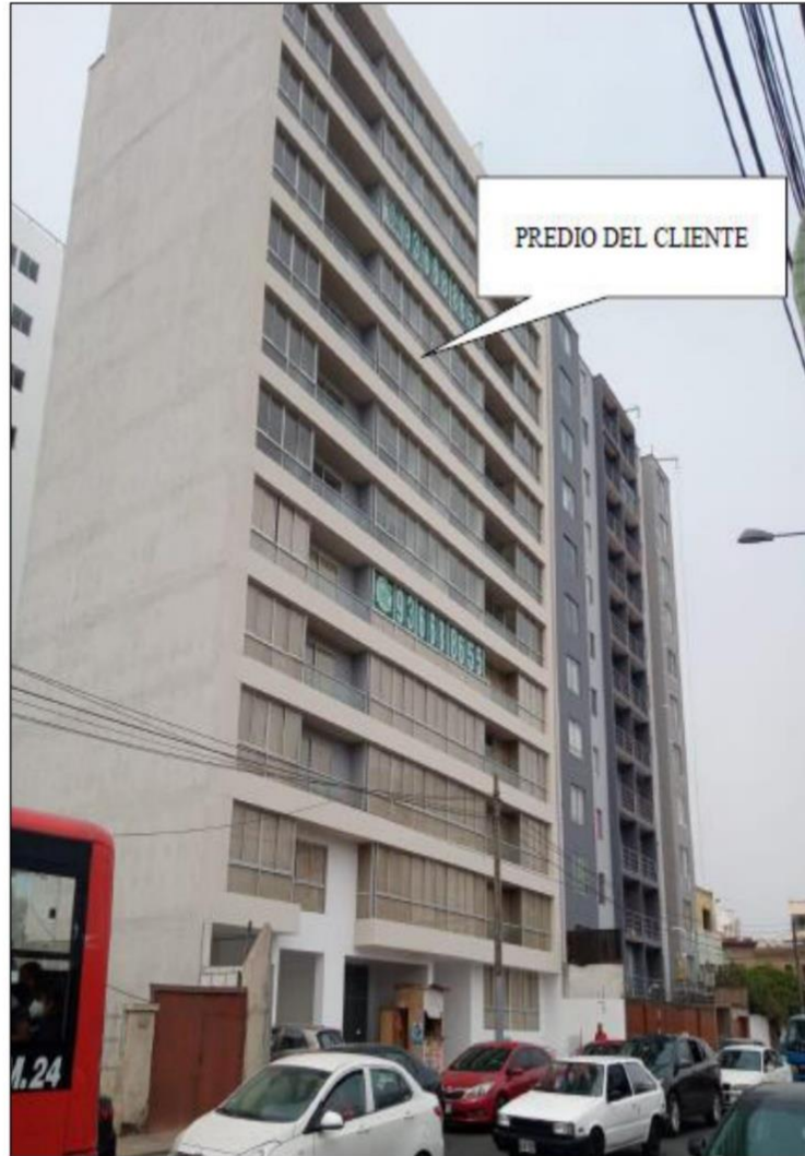
Imagen N°1 Fachada del cliente
