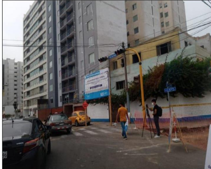
Imagen N°4 Zona de Trabajo
