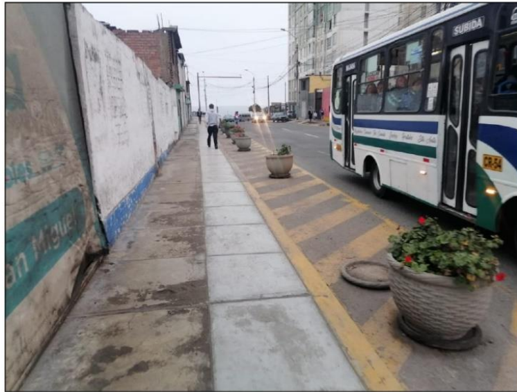
Imagen N°9 Zona de Trabajo
