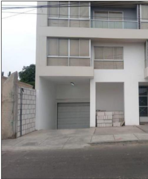
Imagen N°3 Zona de Trabajo
