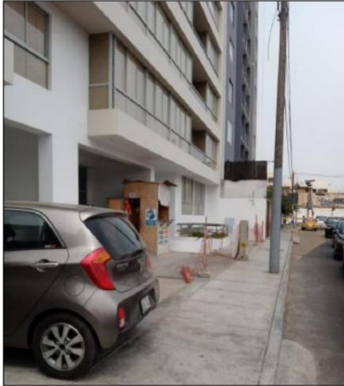
Imagen N°2 Zona de Trabajo
