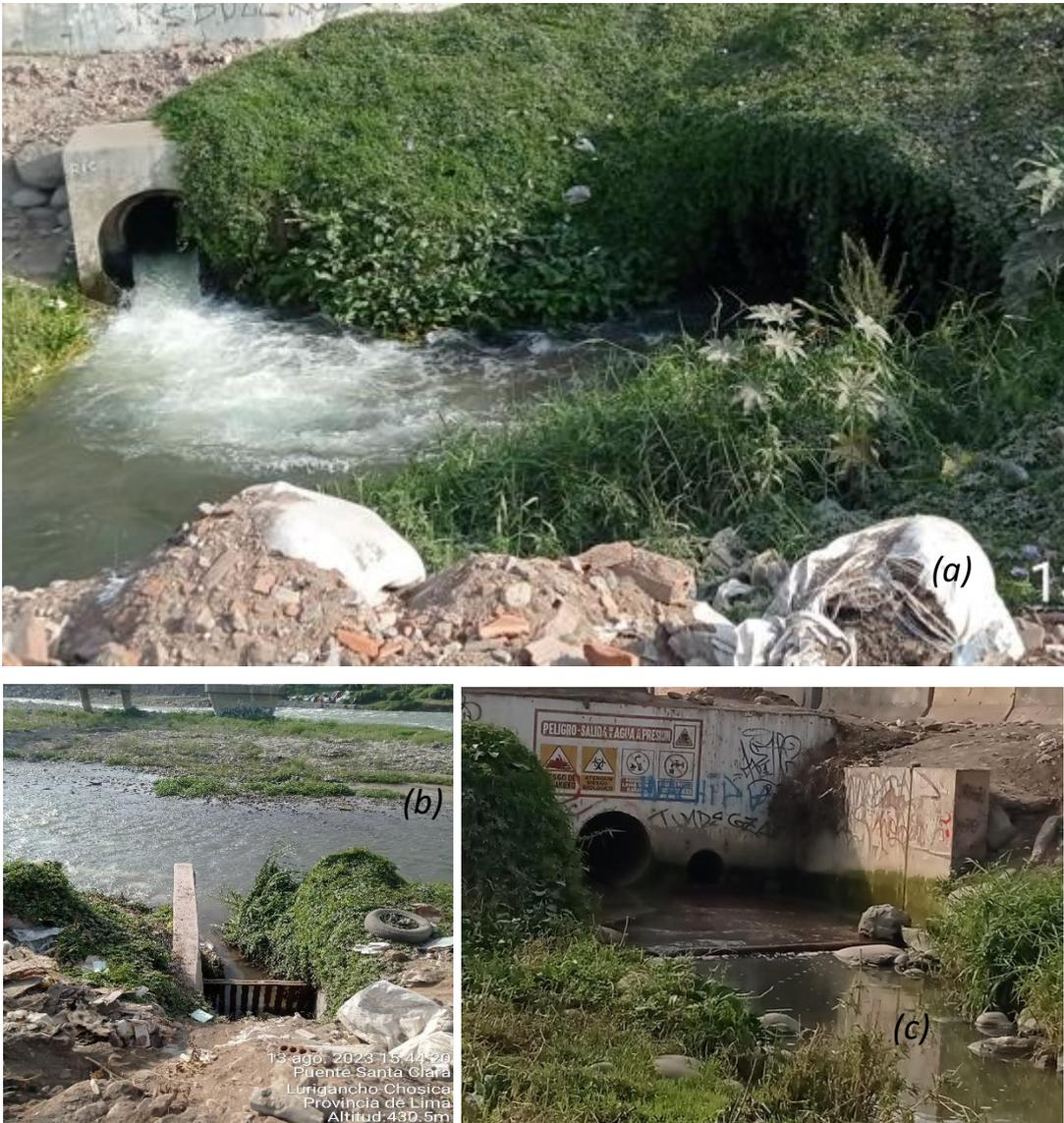
**Nota:** (a) Bocatoma no mapeada encontrada en campo cercana al punto de muestreo (b) Descarga de aguas residuales a cauce del río Rímac (c) Bocatoma 137554\_AR\_IN\_001. Elaboración propia.
