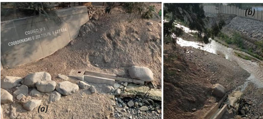
**Nota:** (a) Bocatoma de descarga de aguas residuales (b) Vista del área de toma de muestras.
