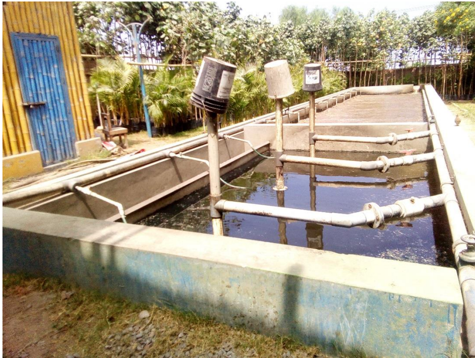
Figura 23. PTAR de Villa El Salvador situada en la Av. Juan Velasco Alvarado con la Av. Pastor Sevilla
