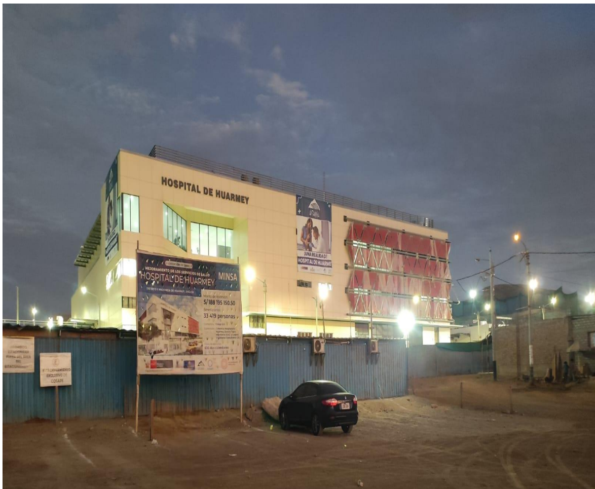
Hospital de Huarney en construcción
