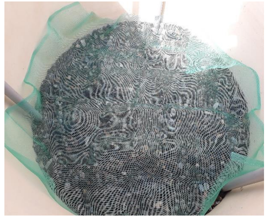
Fotografía 10. Malla mosquitera de nailon para separar las capas filtrantes
