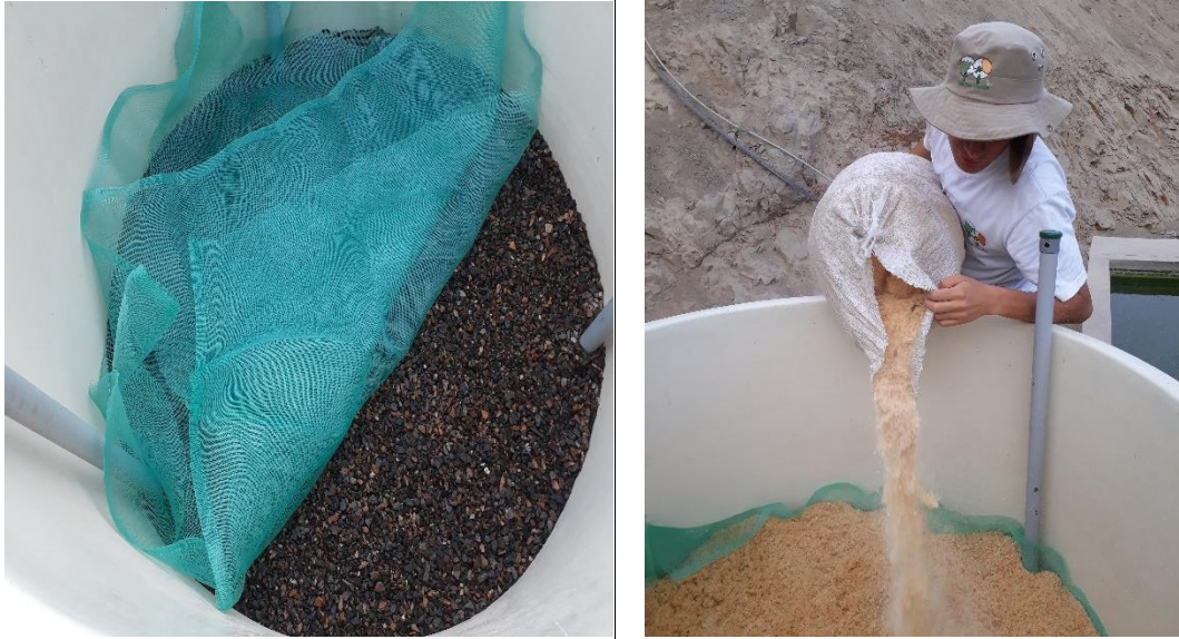
Figura 22 . Empaquetado y llenado de gravilla y aserrín
