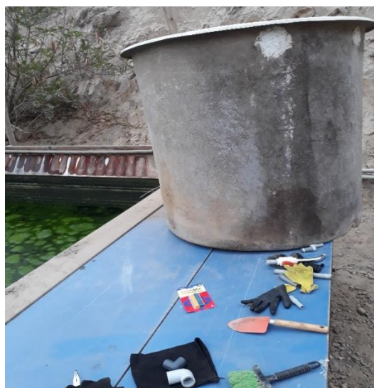
Figura 20. Instalación de la base de apoyo del Lombrifiltro
