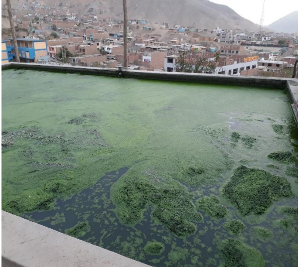
Fotografía 1. Proceso de eutrofización en el estanque de estabilización
