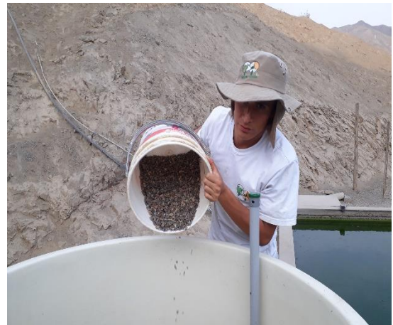
Fotografía 12. Llenado del material gravilla
