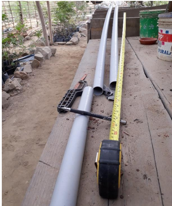
Figura 21. Preparación de los tubos de ventilación
