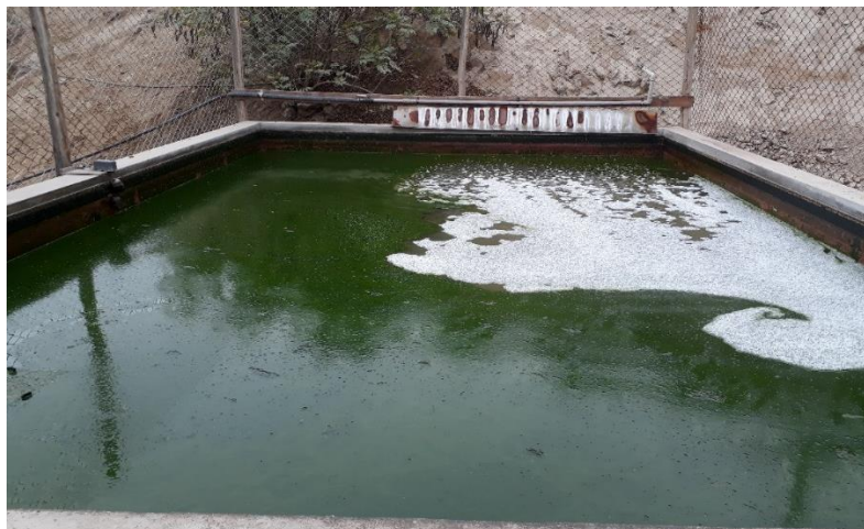
Figura 10. Laguna de estabilización de la PTAR Manchay Verde
