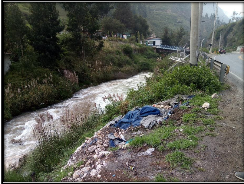
Fotografía N° 01: Acceso a salida de las aguas del túnel Graton.
