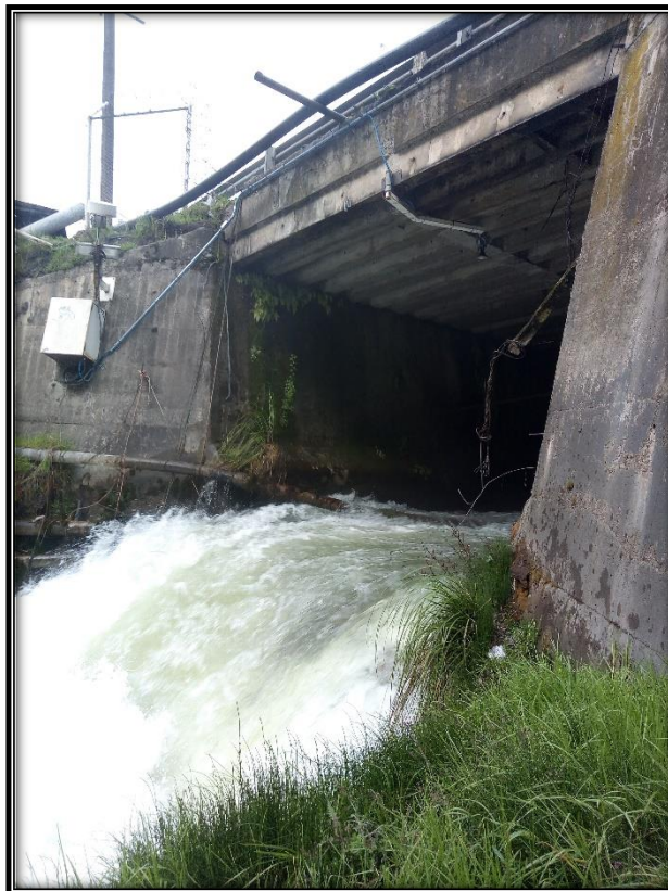
Fotografía N° 04: Salida de las aguas del túnel Graton.
