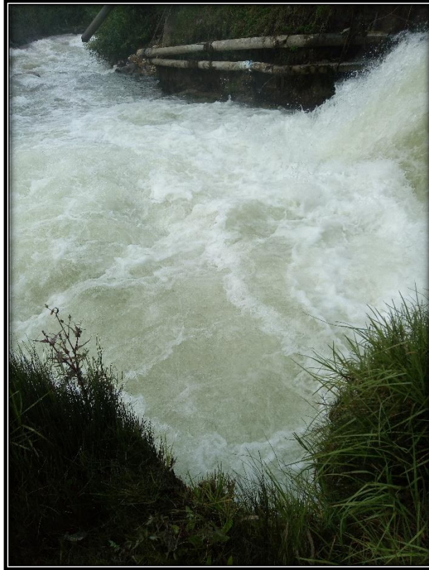
Fotografía N° 05: Zona de vertimiento directo de las aguas del túnel Graton.
