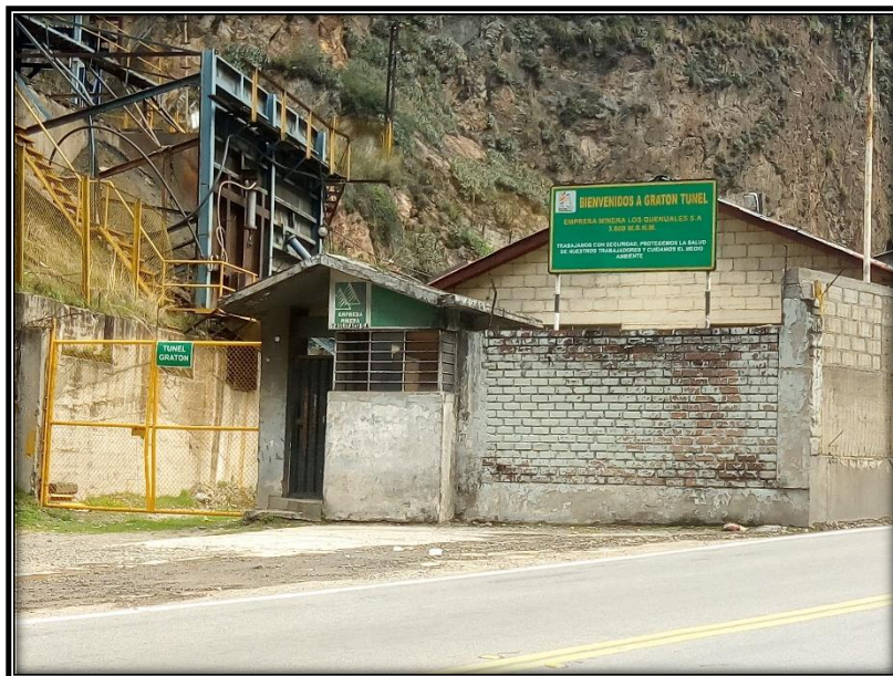
Fotografía N° 12: Instalaciones de Empresa Minera Los Quenuales, a alturas de la salida de las aguas del túnel Graton.
