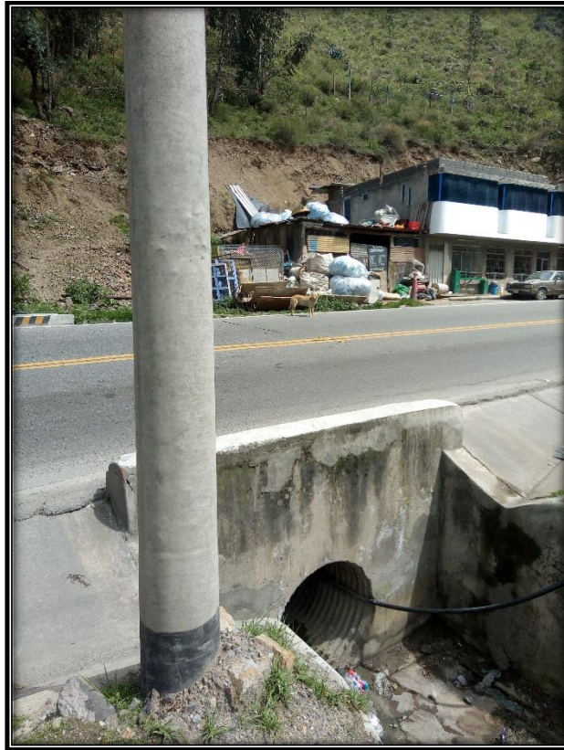
Fotografía N° 19: Infraestructuras en caso de activación de quebrada con dirección hacia el río Rimac altura del punto de muestreo R04-RIMAC.
