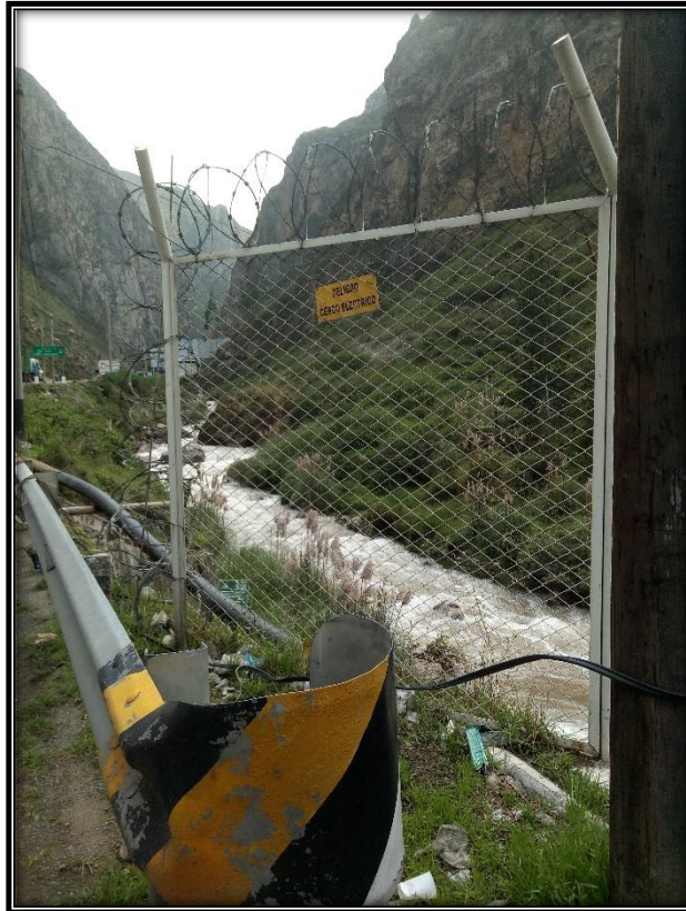
Fotografía N° 11: Malla metálica electrificada instalada por Empresa Minera Los Quenuales
