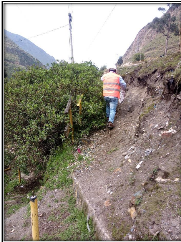
Fotografía N° 02: Bajada a la salida de las agua del túnel Graton.
