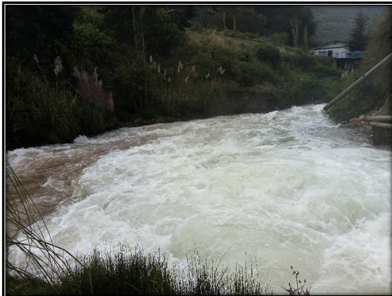
Fotografía N° 06: Encuentro de las aguas del río Rímac y el túnel Graton.
