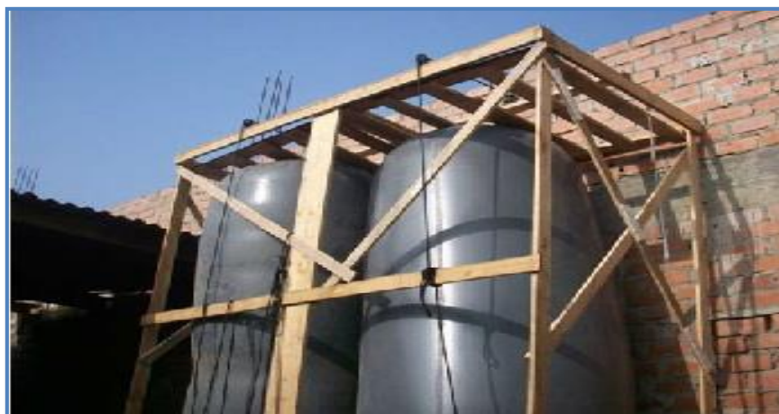
Figura 9. Tanque de biogás (Polietileno). Fuente. “Biodigestores familiares guía de diseño y manual de instalación”, p.32, por Herrero J. 2008, Bolivia: Ediciones Creative Commons.
