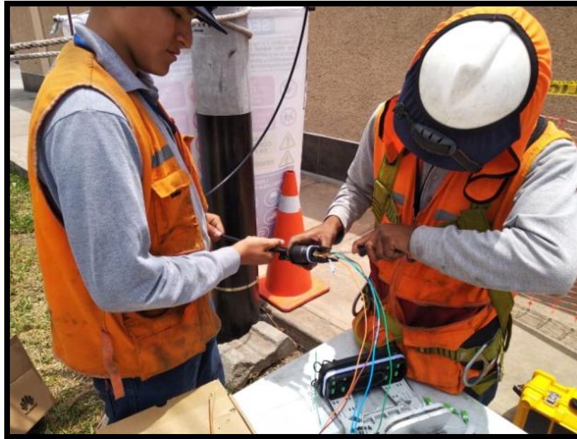
Figura 49. Acondicionamiento de la fibra.
