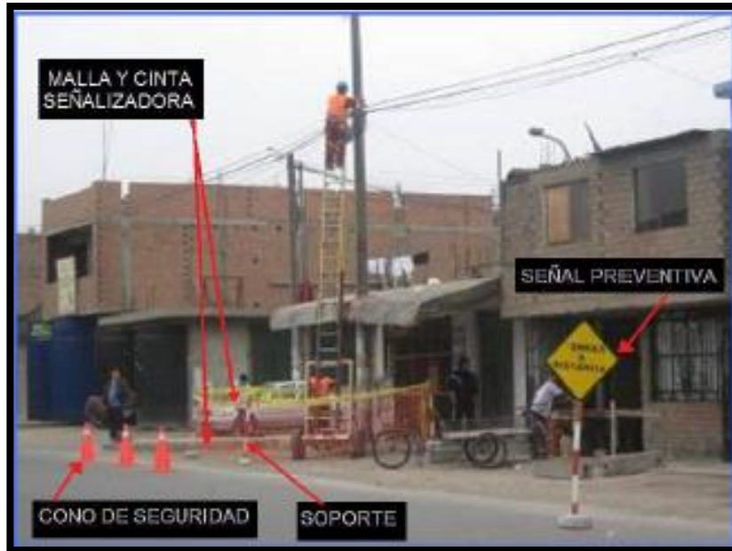
Figura 37. Seguridad en la zona de trabajo.
