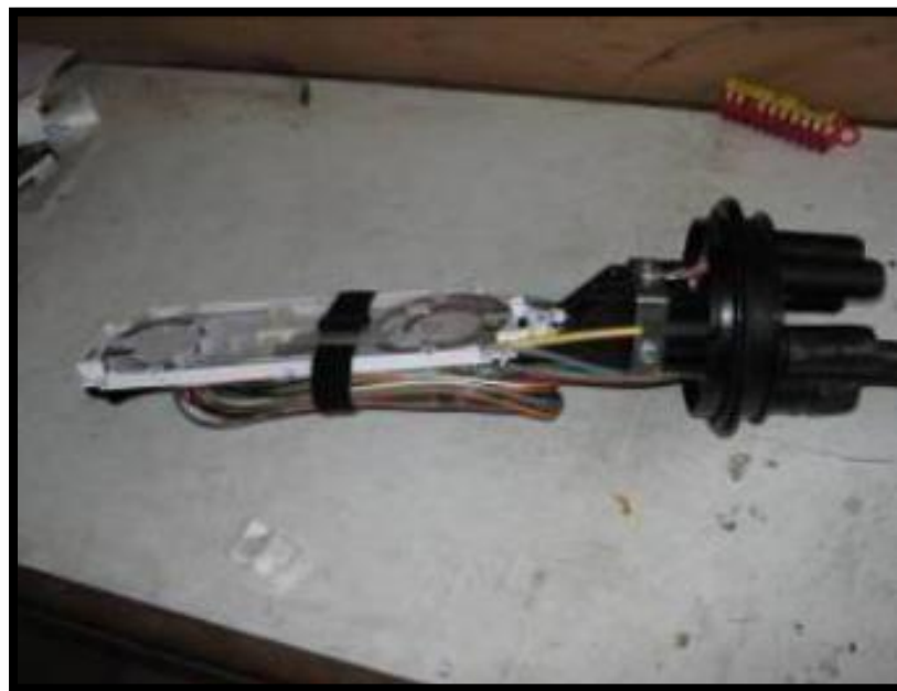
Figura 52. Acondicionamiento de buffer a empalmar.
