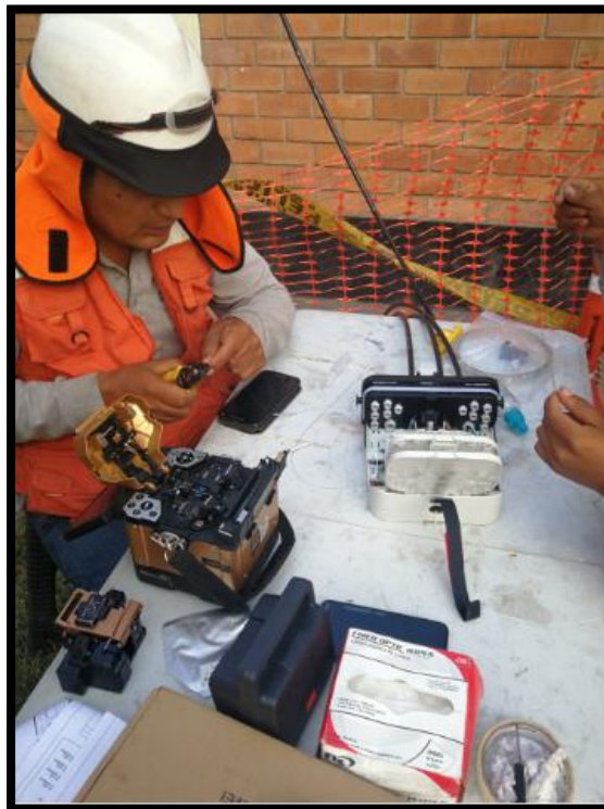
Figura 54. Proceso de empalme por fusión.
