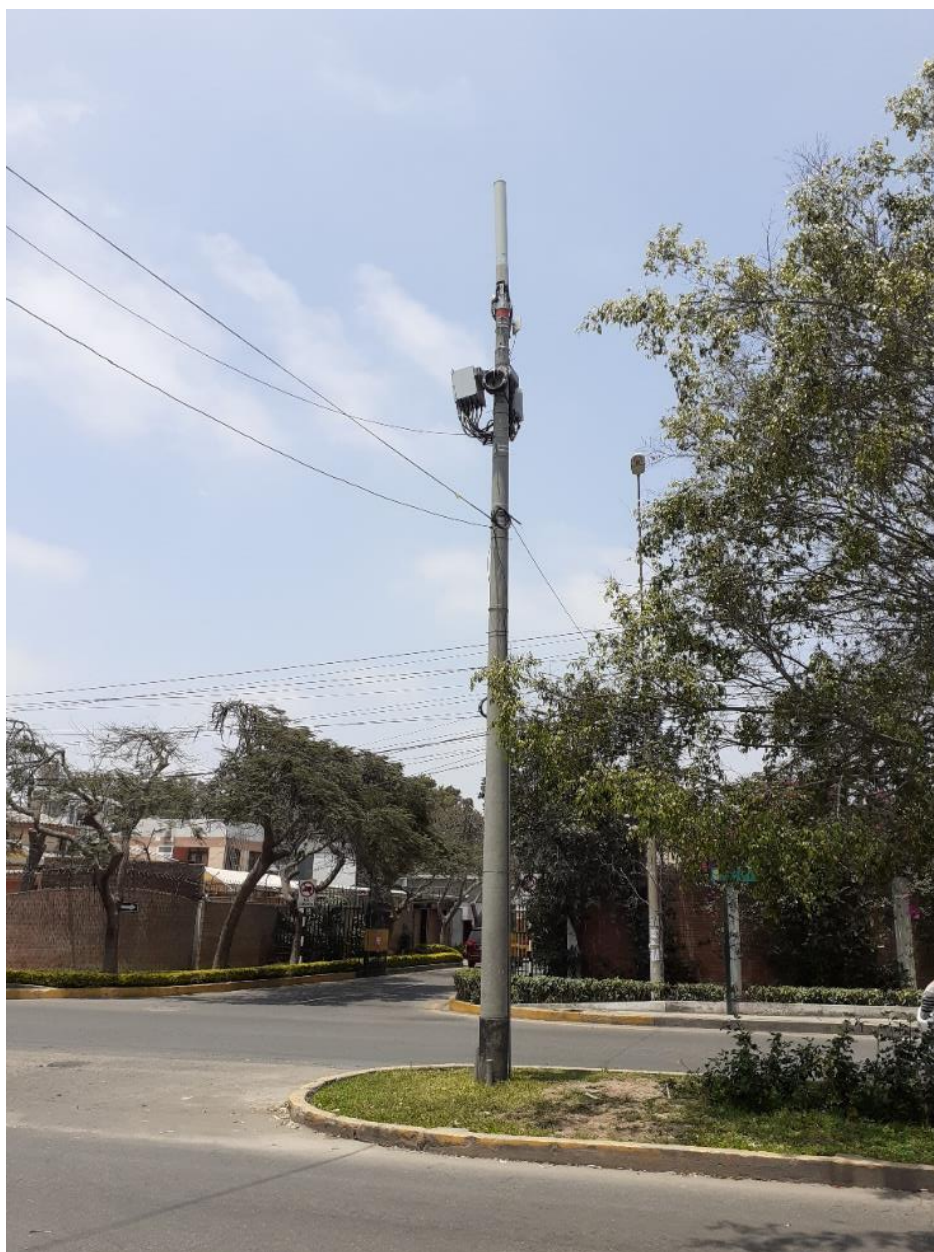
Figura 20: Figura muestra poste18 (nuevo) de 11 metros con antena tipo Pole Site instalada.
