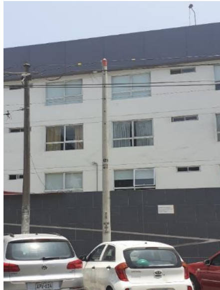
Figura 18: Figura muestra poste6 (nuevo) con fibra óptica y rotulado en etiquetas
