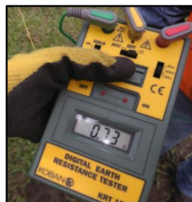
Figura 63. Datos de medición de la puesta a tierra Fuente: Elaboración propia
