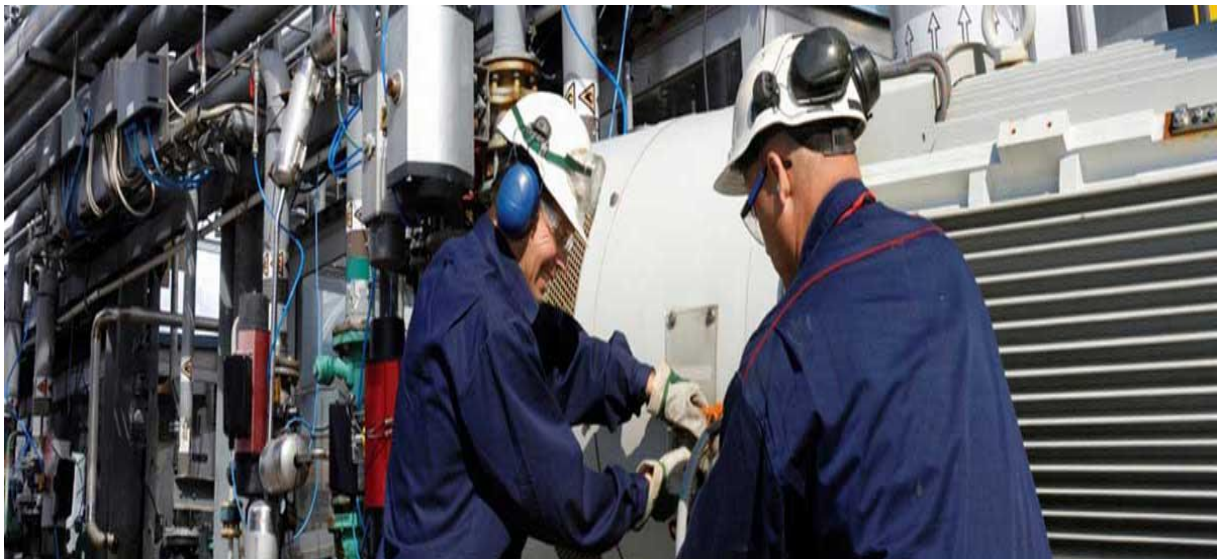
Figura 2: Ejecución de mantenimiento
