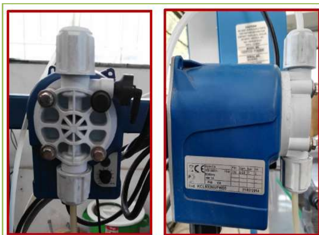
FIGURA N° 19: BOMBA_DOSIFICADORA DE PERÓXIDO DE HIDROGENO
