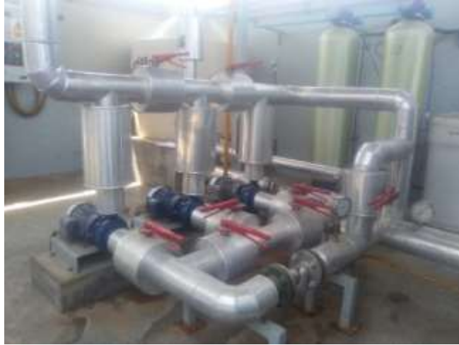
Figura N°3.1. Sistema de bombeo de agua.
