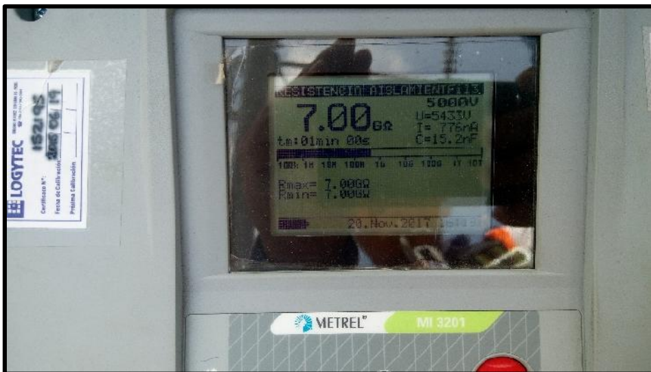
Figura 64 - Resultado de Resistencia de aislamiento de Baja a Tierra
