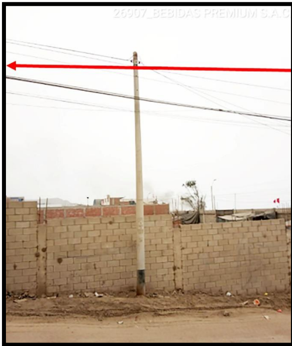
Figura 25: Detalle de poste 06 Optical Networks en Calle 14
