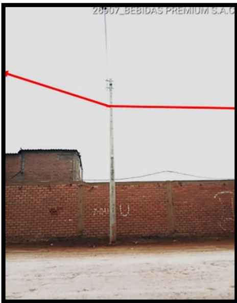
Figura 34: Detalle de poste 15 LDS. en Calle 6
