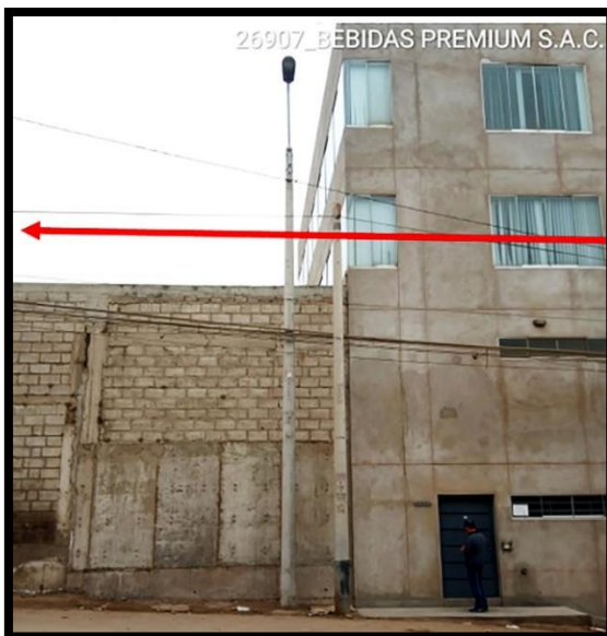
Figura 27: Detalle de poste 08 Optical Networks. en Calle 14
