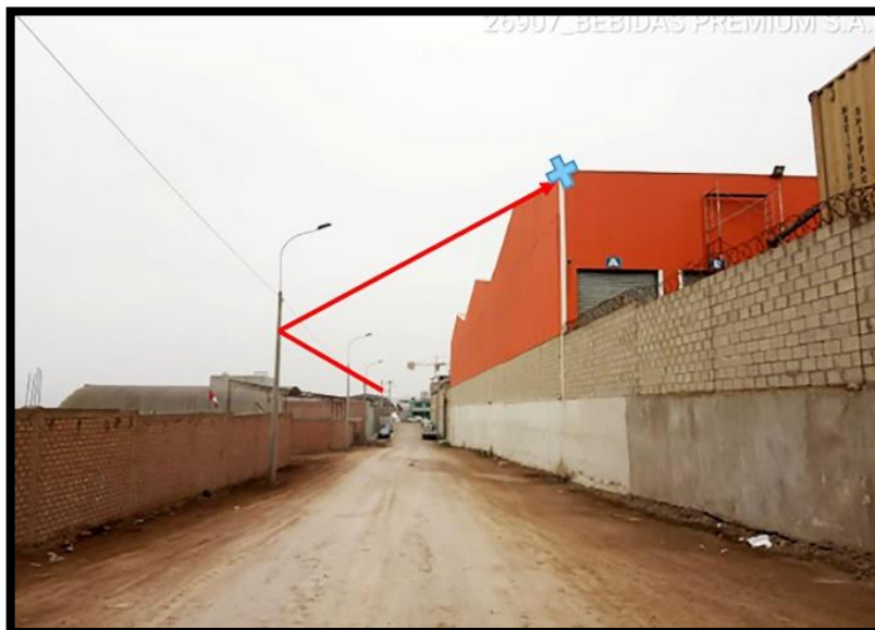
Figura 35: Detalle de ingreso aéreo al almacén del cliente
