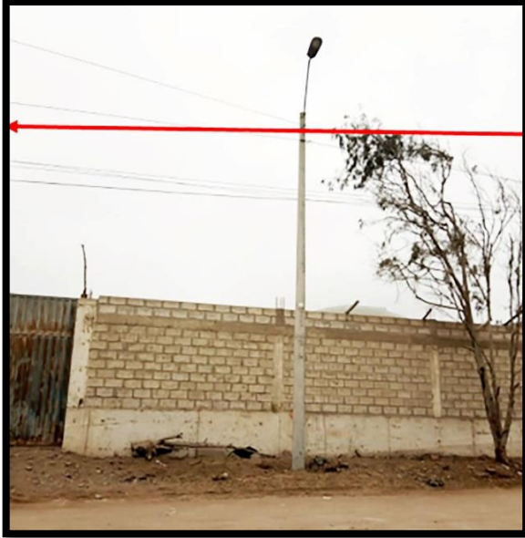
Figura 21: Detalle de poste 02 LDS en Calle 5
