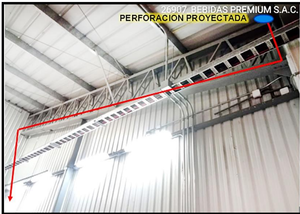
Figura 37: Detalle de ingreso al interior del almacén del cliente
