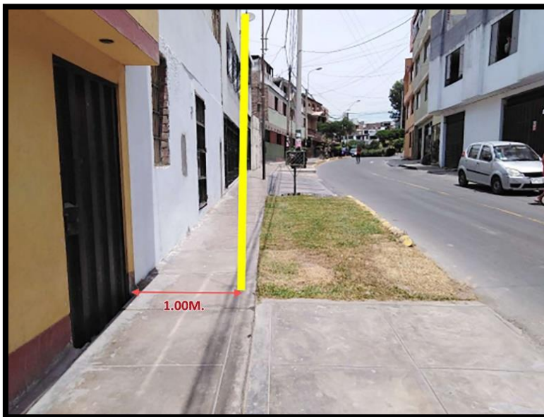
Figura 10: Instalación de plantar poste.
