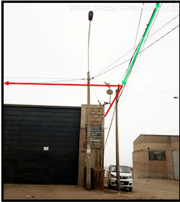
Figura 29: Detalle de poste 10 LDS. en Calle 6
