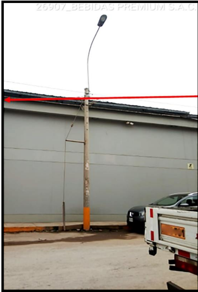
Figura 31: Detalle de poste 12 LDS. en Calle 6
