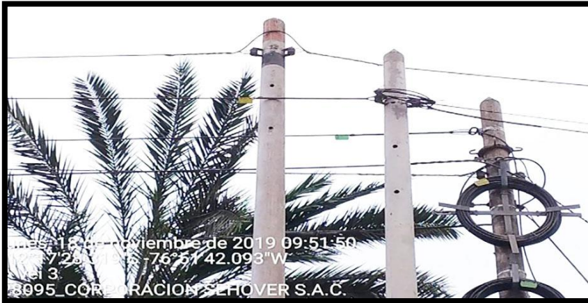
Figura 19: Modelo correcto de instalar la ferretería en el poste
