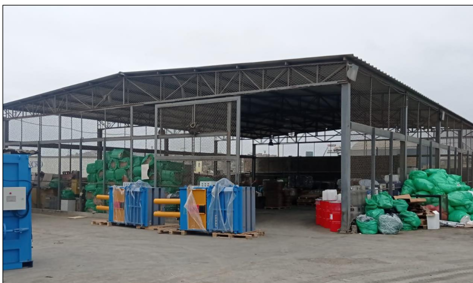
Figura 9. Zona de almacenamiento. Fuente: propia, 2021.
