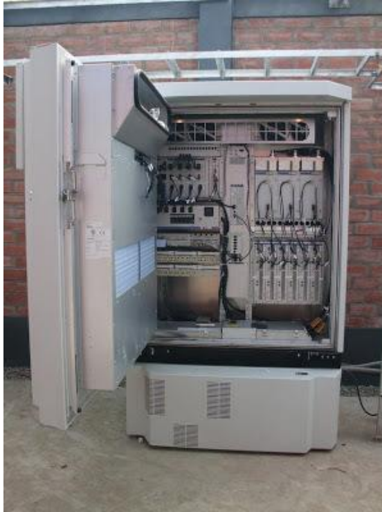
Figura 28: Equipo Radio Base - Ericson 2106 tipo Outdoor
