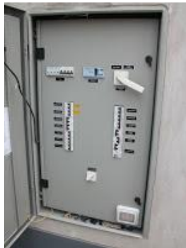
Figura 20: Tablero eléctrico.
