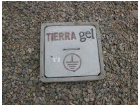
Figura 22: Pozo de tierra.
