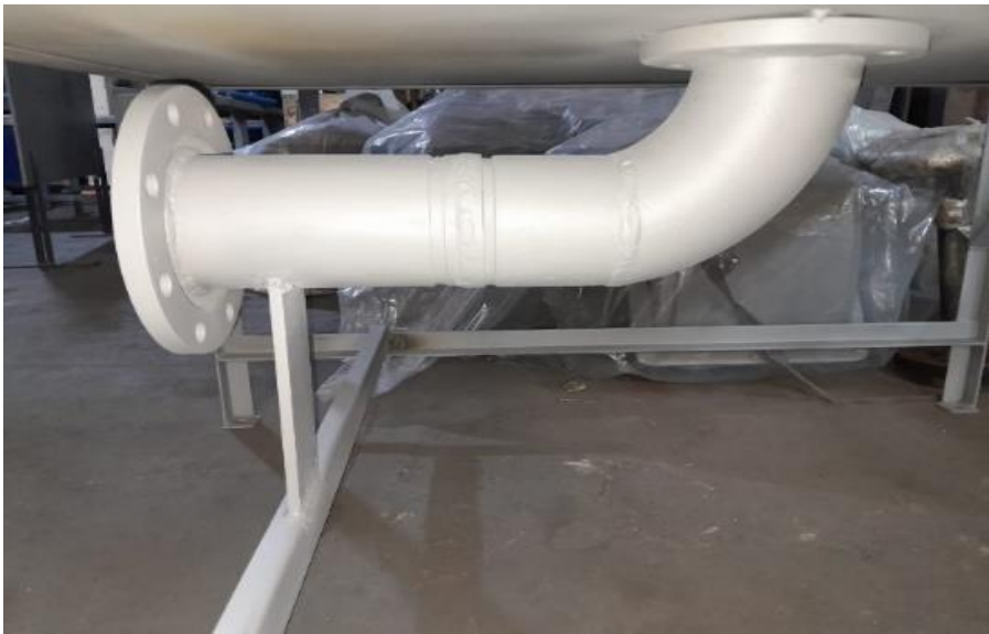
Soldadura de tubería de succión a tanque de almacenamiento
