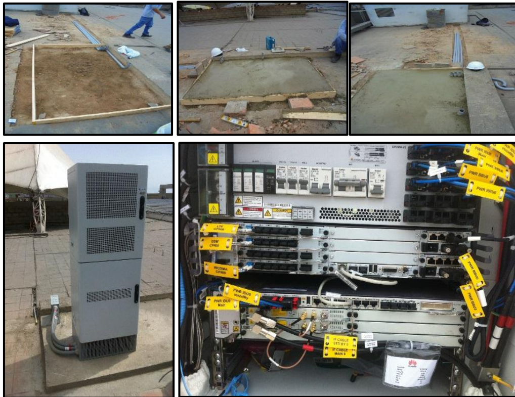
Figura 3-30 Instalación de la BBU
