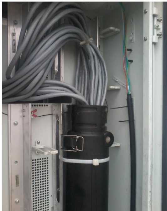
Figura 26. Instalación de manga para protección de los pares de cobre
