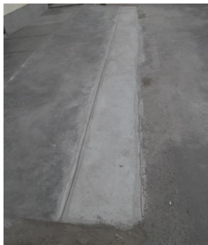
Figura 17. Canalización auxiliar del DSLAM hacia el Armario
