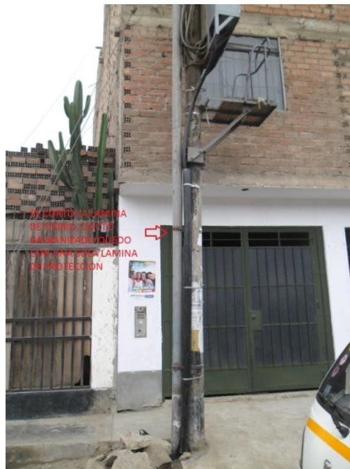
Figura 22. Instalación del suplemento en el Armario
