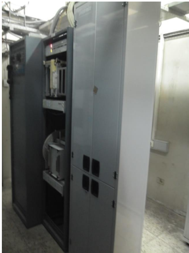
Figura 3. ODF de tipo electroson
