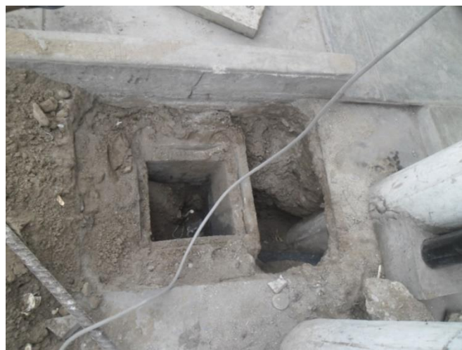
Figura 31. Instalación de la puesta tierra
