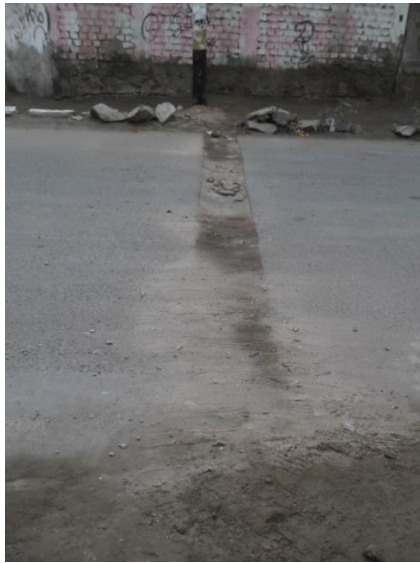
Figura 19. Canalización de DSLAM hacia poste de luz del sur para alimentación
