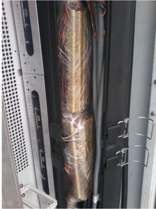
Figura 25. Peinado del multipar con galletas de 25 pares dentro del DSLAM
