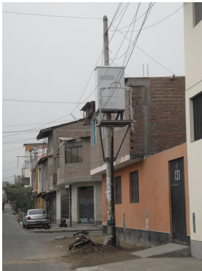
Figura 21. Instalación del DSLAM en poste
