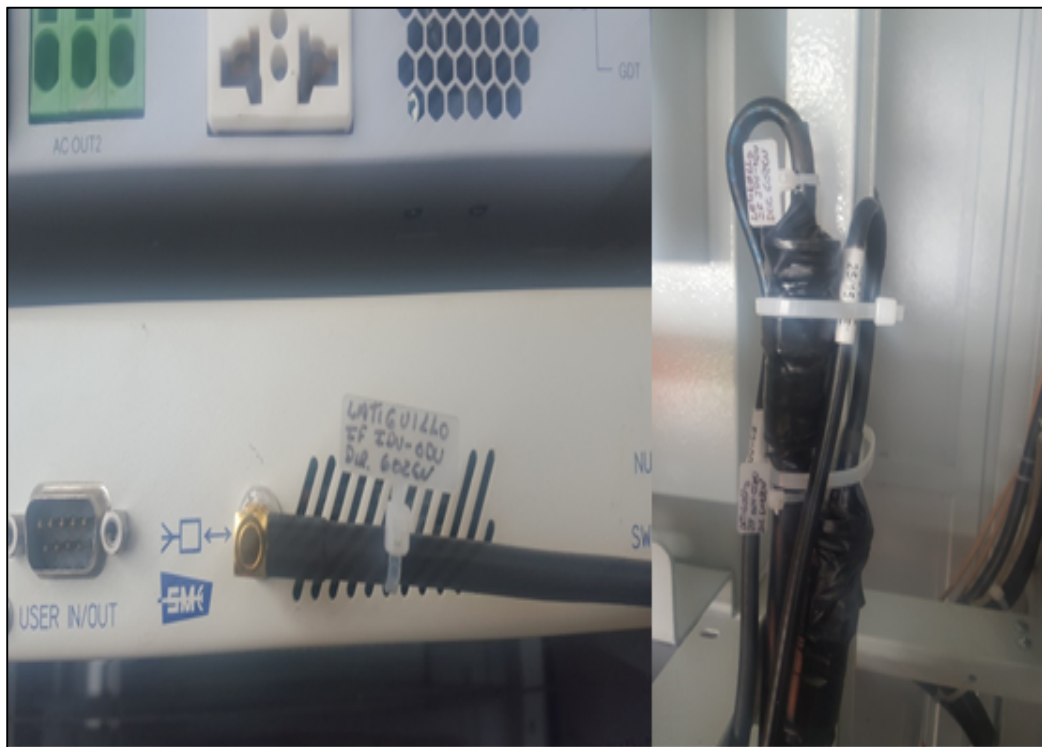
Figura 3.8 – Conexión IDU - latiguillo y Rg-8
