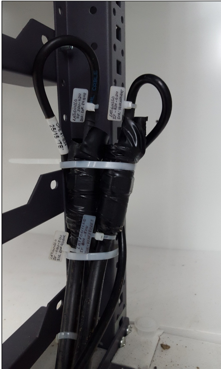
Figura 3.12 – Conexión latiguillo y Rg-8
