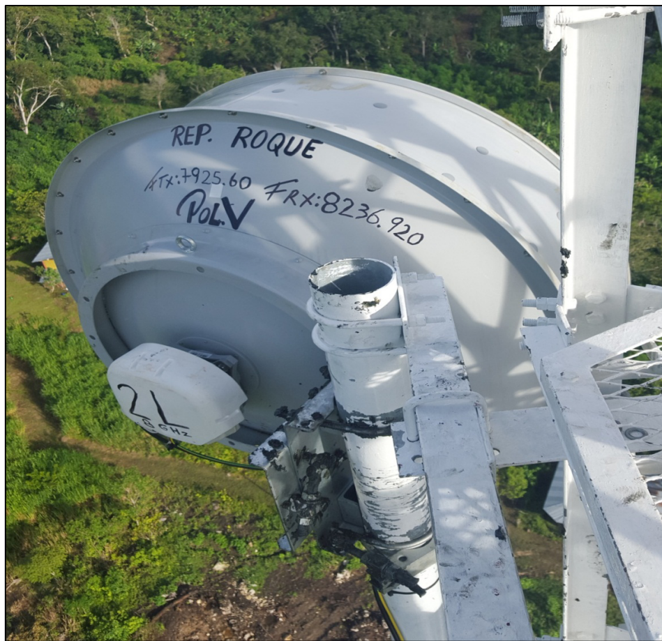
Figura 3.13 – Instalación de antena
