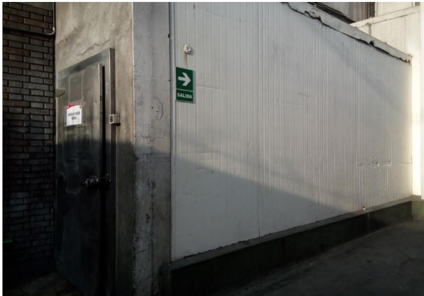
Foto N° 06: Cámara de frío para residuos de huesos y mermas. Medidas de 8 x 1.80m2 aprox.
