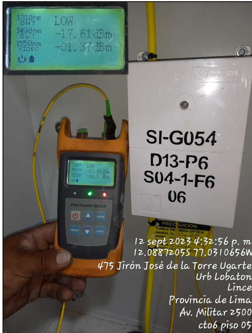
Nota: Medición de potencia óptica con PON Power Meter en el Piso 05, denominado CTO 06. Elaboración propia.
