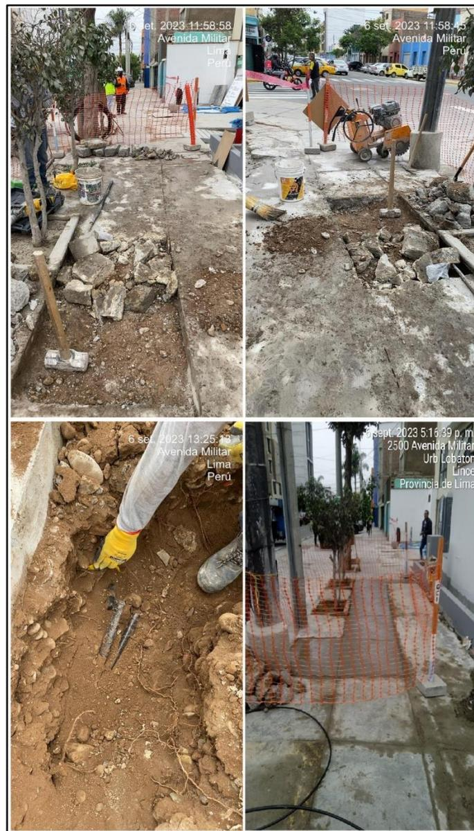
*Nota:* Imágenes del proceso de canalizado y reposición de vereda para el edificio multifamiliar. Elaboración propia.
