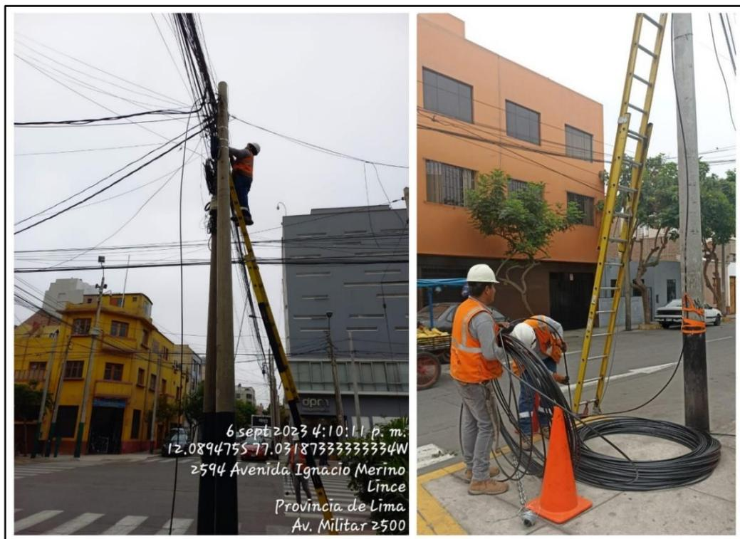
*Nota:* Imágenes del tendido de la planta externa por medio del cable PKP de 16 hilos. Elaboración propia. (2023)
