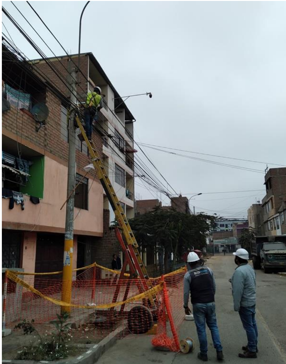
Figura 20 Supervisión de instalación de ferretería en Ate
