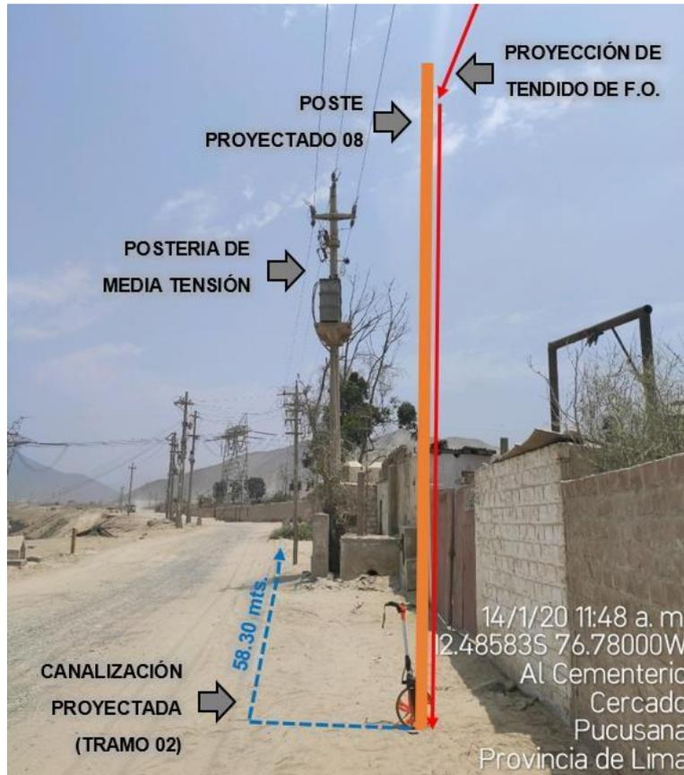
Figura 17. Poste proyectado 08 y segundo tramo de canalización proyectada
