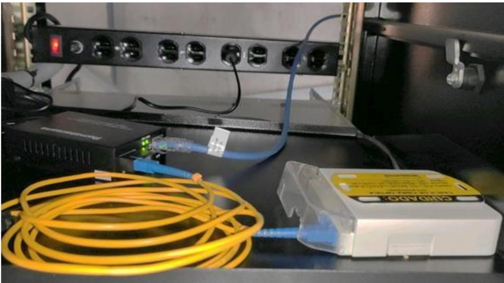
Figura 30. Roseta óptica y media converter instalados.
