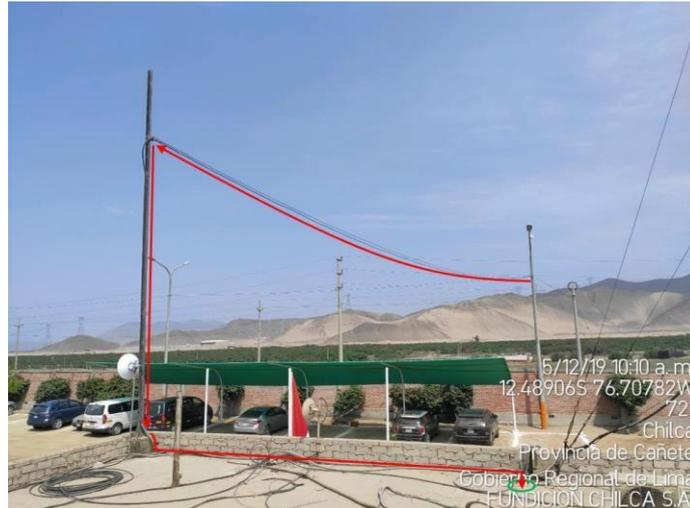
Figura 28. Recorrido interno del cableado de fibra óptica
