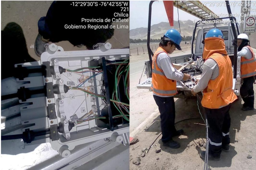
Figura 25. Instalación de Mufa Mondragón y fusiones en la fibra óptica
