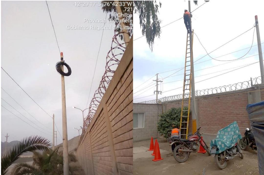
Figura 27. Despliegue del cableado de fibra óptica en postes instalados
