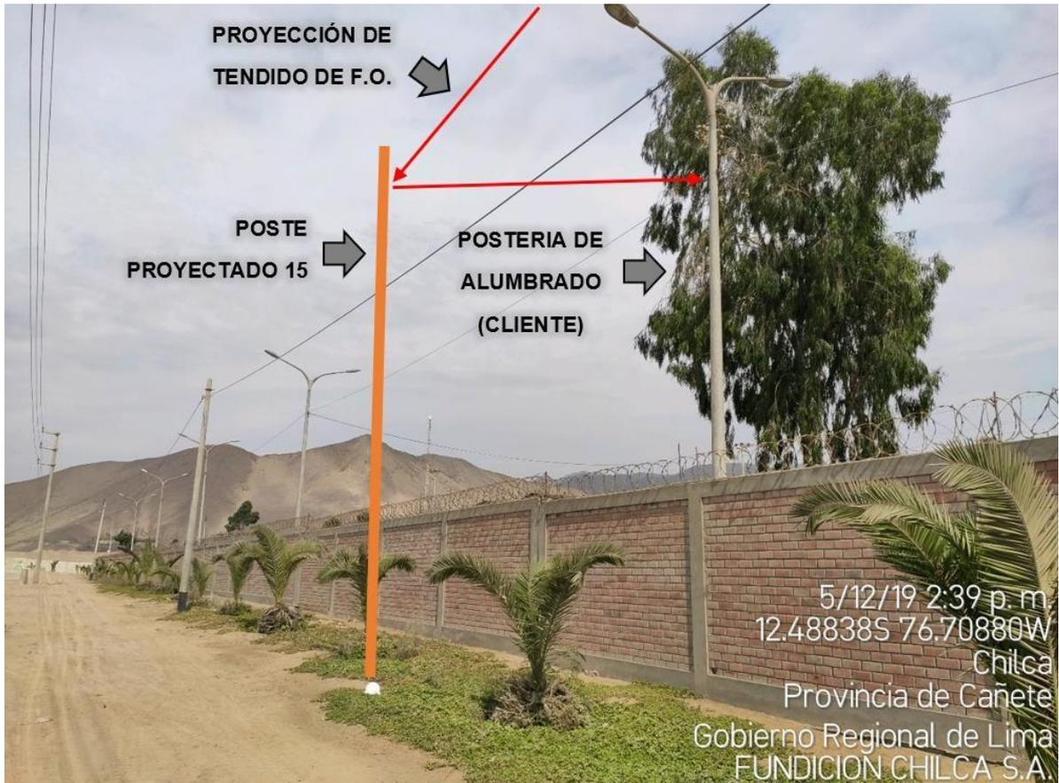
Figura 19. Poste proyectado 15 y acceso aéreo proyectado al interior de predio
