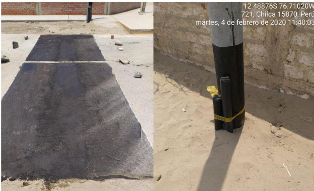
Figura 24. Reposición de canalizado en PCA y llegada de tubería a poste instalado
