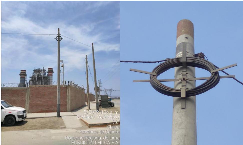
Figura 14. Reserva de fibra óptica en poste de operador de internet
