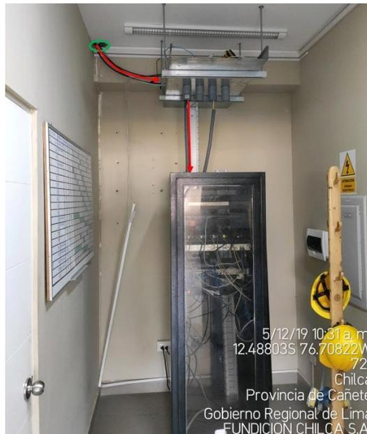
Figura 29. Llegada de cableado de F.O. hacia cuarto de comunicaciones
