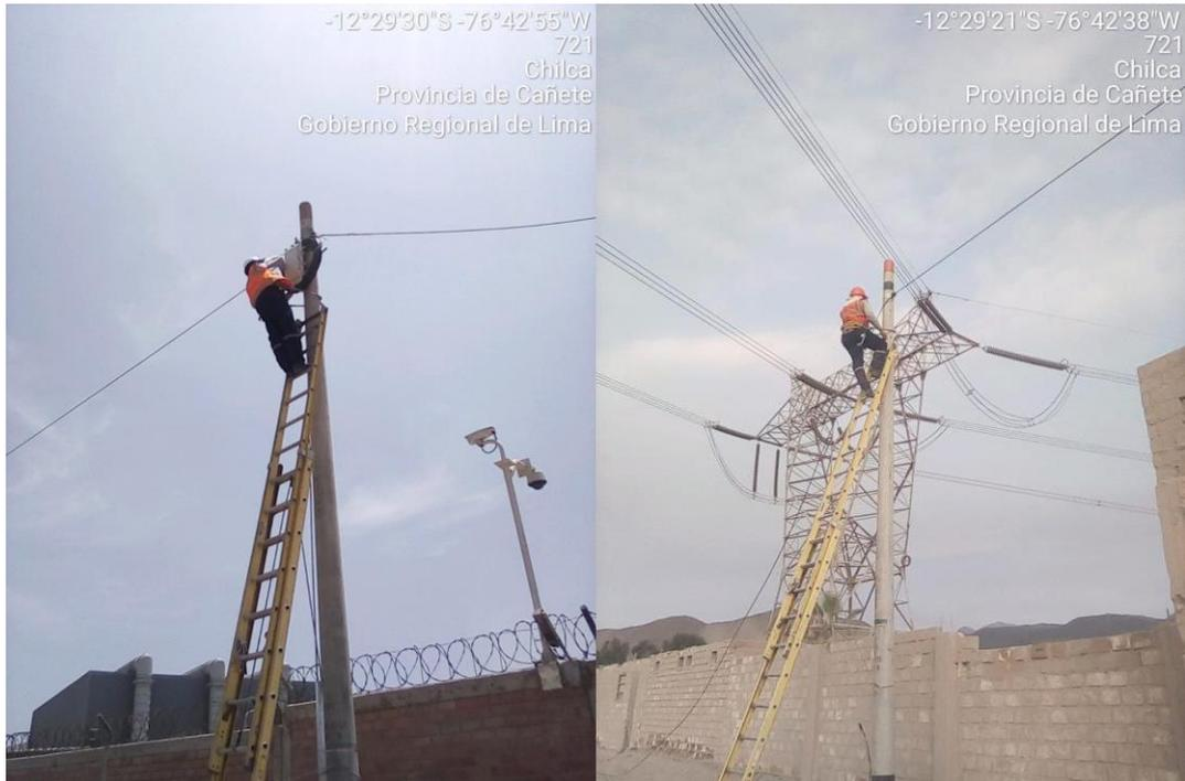
Figura 26. Acondicionamiento de mufa en poste e instalación de cableado de fibra óptica
