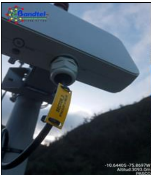
Figura 81. Instalación de IAO PA-0211-CS01 Fuente: Elaboración propia
