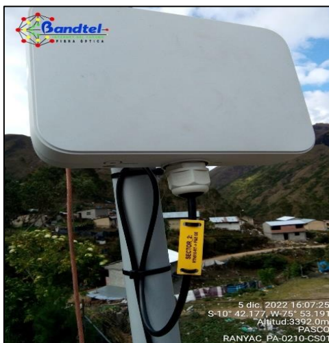
Figura 89. Instalación de IAO PA-0210-CS01
