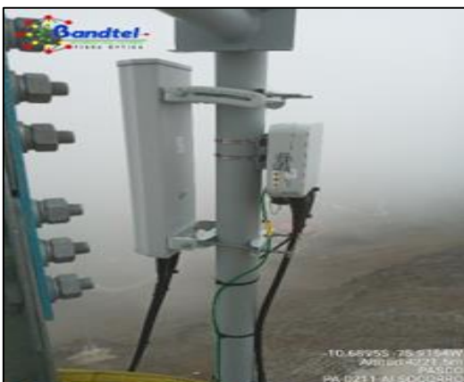
Figura 75. Instalación de sectorial 1 en el nodo Socorro Fuente: Elaboración propia
