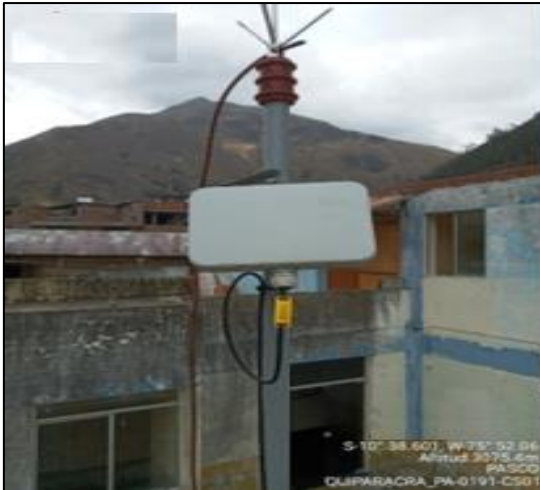
Figura 74. Instalación de IAO PA-0191-CS01 Fuente: Elaboración propia
