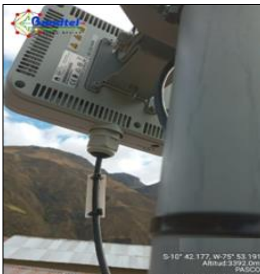
Figura 84. Instalación de IAO PA-0234-IE01 Fuente: Elaboración propia
