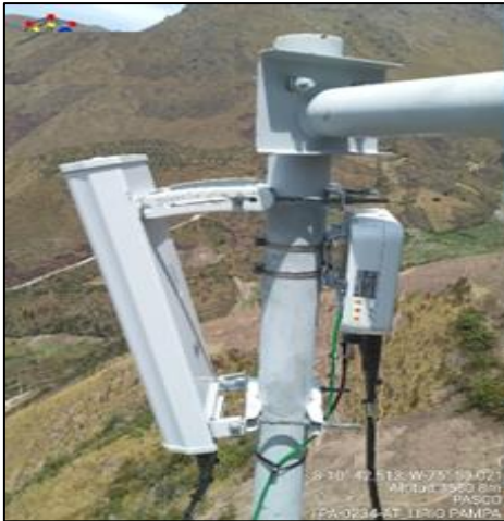
Figura 86. Instalación de sectorial 2 en el nodo Lirio Pampa Fuente: Elaboración propia
