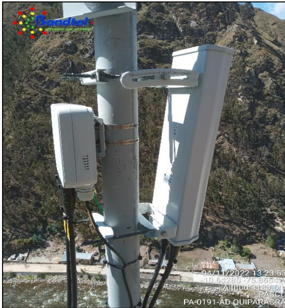
Figura 67. Instalación de sectorial 1 en el nodo Quiparacra Fuente: Elaboración propia
