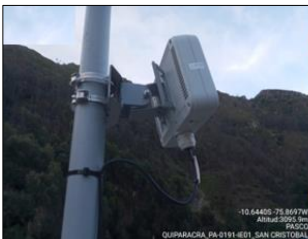
Figura 73. Instalación de IAO PA-0191-IE01 Fuente: Elaboración propia
