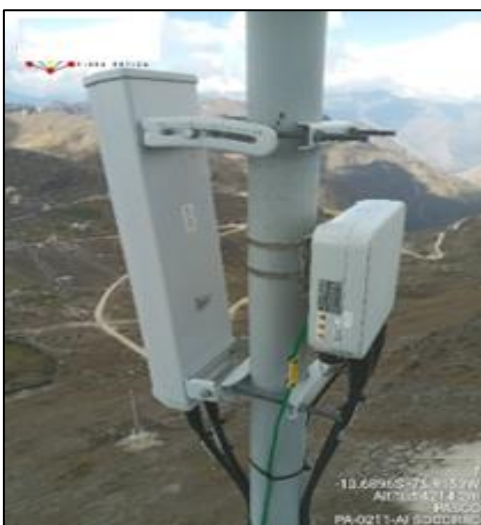
Figura 78. Instalación de sectorial 2 en el nodo Socorro Fuente: Elaboración propia
