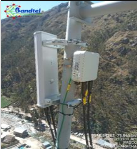
Figura 71. Instalación de sectorial 2 en el nodo Quiparacra Fuente: Elaboración propia
