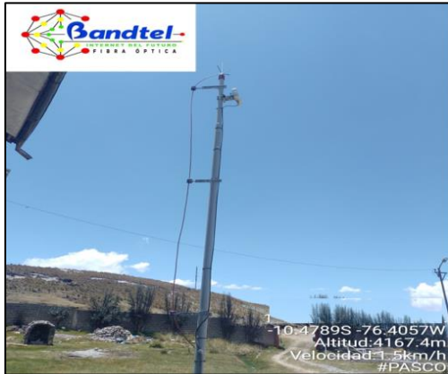
Figura 88. Instalación de IAO PA-0210-IE02
