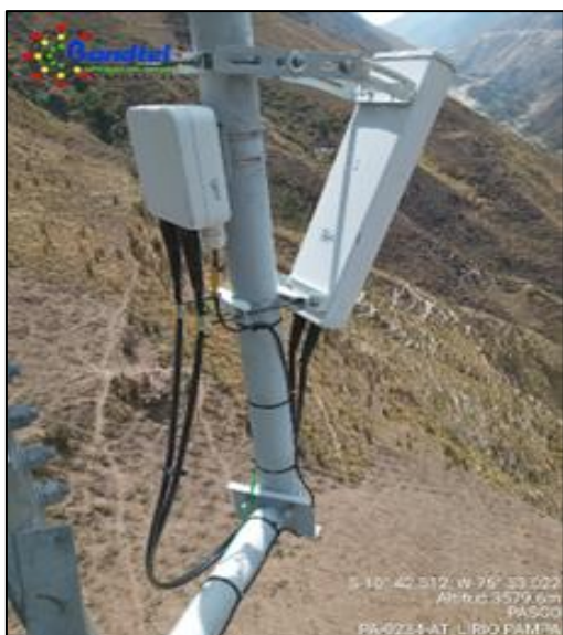
Figura 82. Instalación de sectorial 1 en el nodo Lirio Pampa Fuente: Elaboración propia
