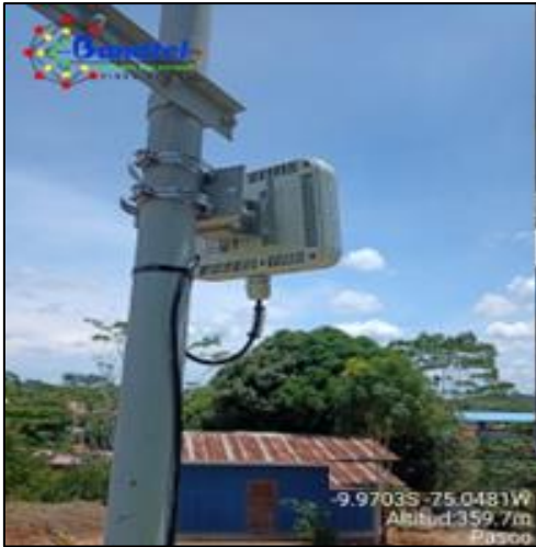
Figura 80. Instalación de IAO PA-0211-IE02 Fuente: Elaboración propia
