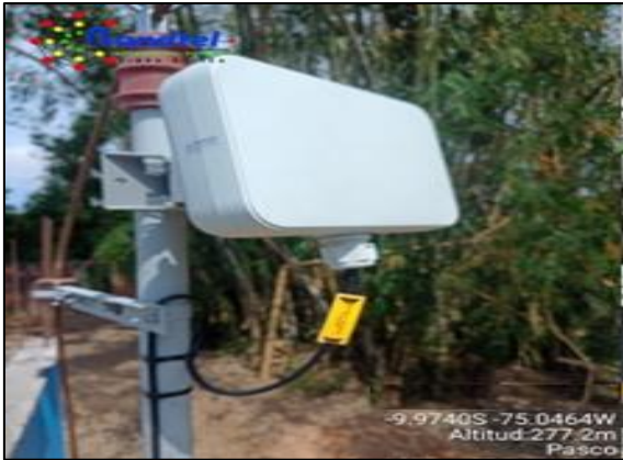
Figura 77. Instalación de IAO PA-0211-IE01 Fuente: Elaboración propia
