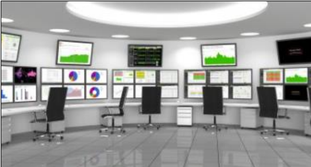
Figura 11 Centro de Operaciones de Redes.
