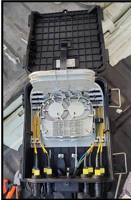
*Figura 43. Acondicionamiento de hilos en XBOX*
