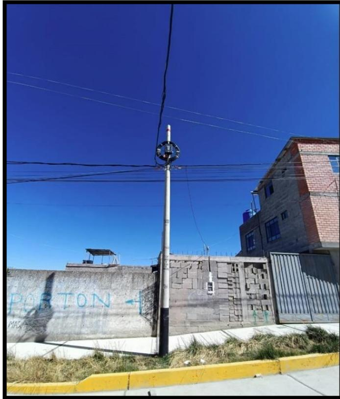
*Figura 44.* Acondicionamiento de XBOX en poste
