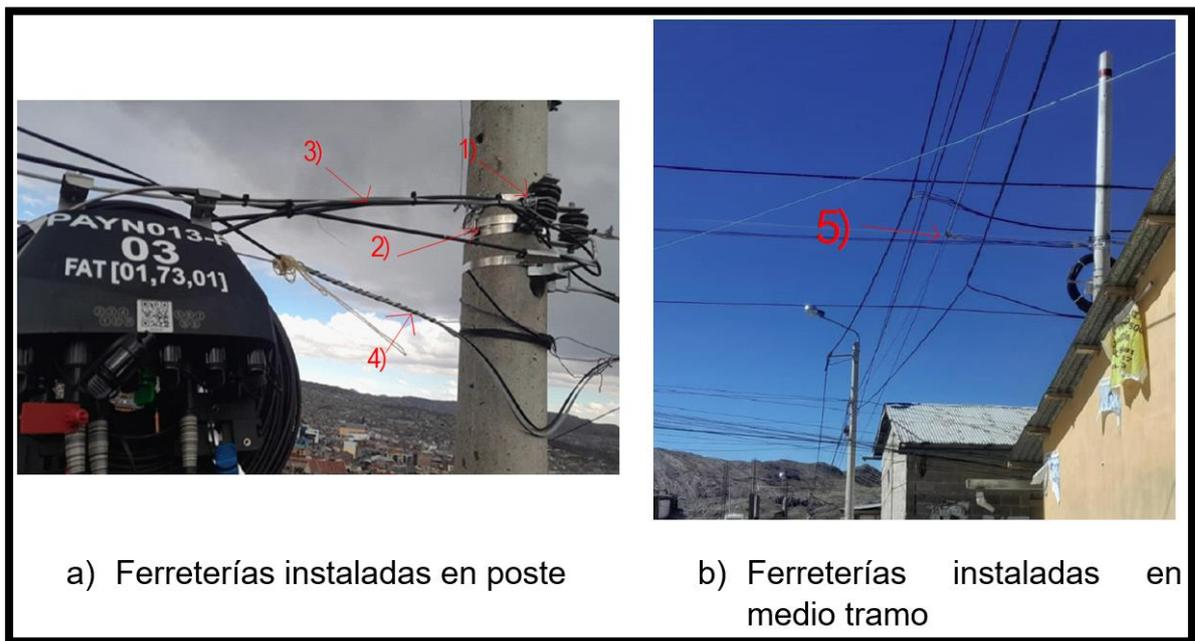
Figura 55. Reporte fotográfico de ferretería instalada
