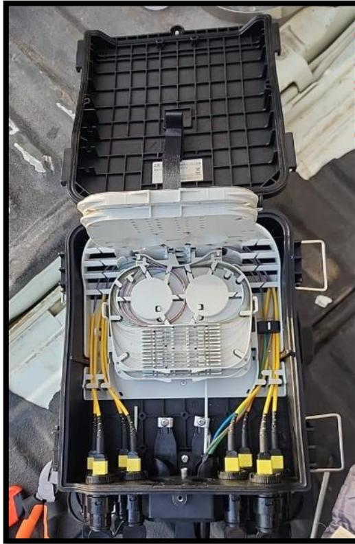
*Figura 43. Acondicionamiento de hilos en XBOX*
