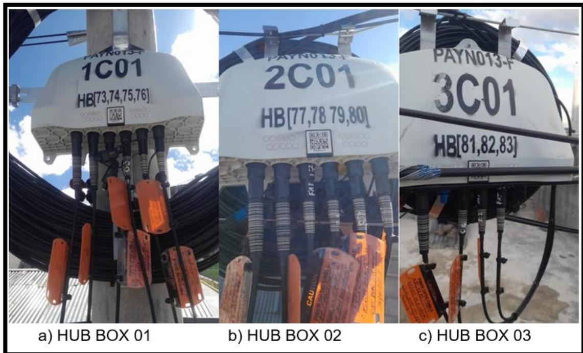
*Figura 46.* Acondicionamiento de HUB BOX en postes
