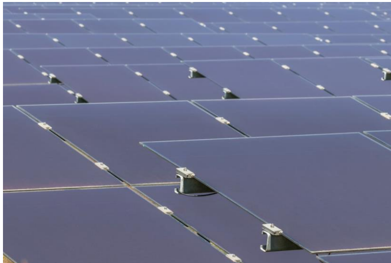
Panel solar de silicio amorfo
