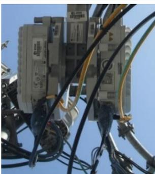
ODUS con etiquetas indicando MAIN y STAND BY. También el tipo de polarización y frecuencia de transmisión y recepción.
