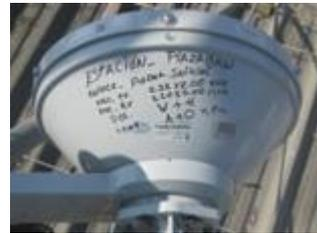
Etiquetado y engrasado del aterramiento de las ODUS
