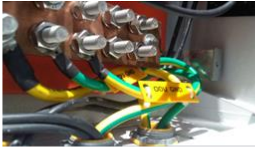
Aterramiento de las ODUS con sus respectivas etiquetas
