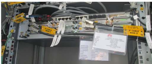
Etiquetado de las tarjetas 4 y 6 colocadas en la IDU
