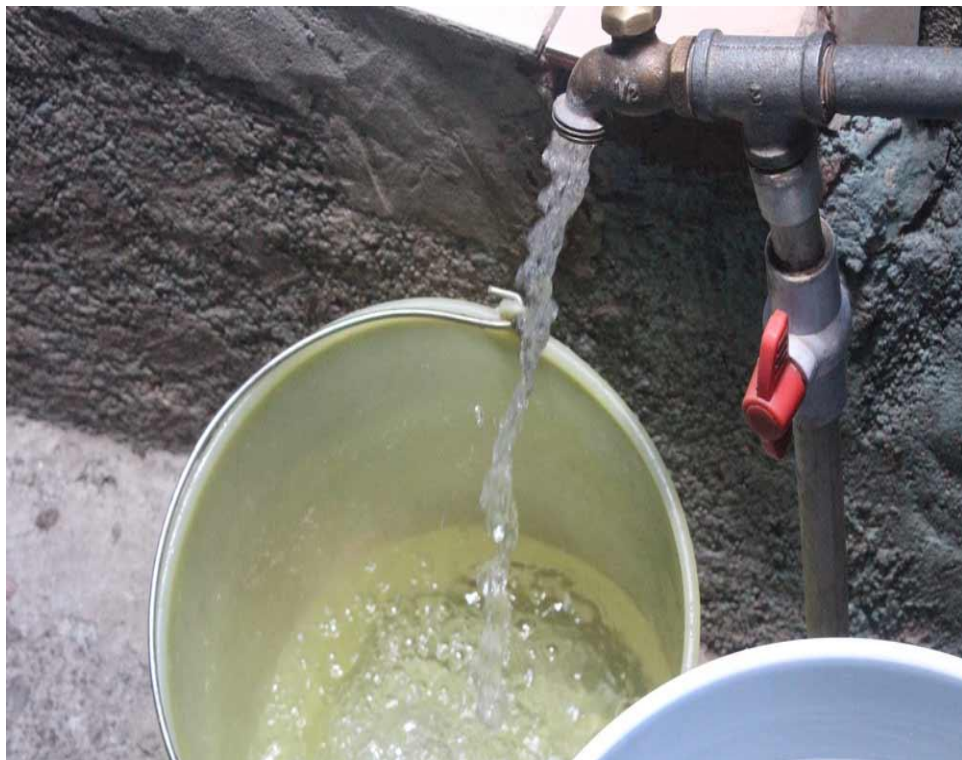
Instalación de reguladores de agua en almacén.
