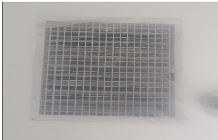
Figura 10 – Instalación de rejillas de suministro
