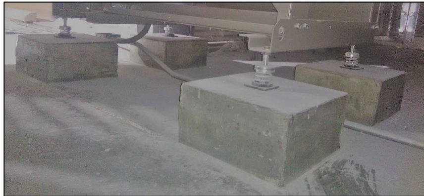
Figura 11 – Base de concreto para equipos en Sótanos
