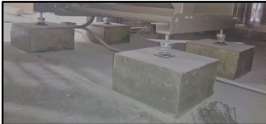
Base de concreto para equipos de presurización de escaleras en Sótanos
