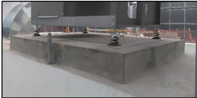
Base de concreto para equipos de presurización de escaleras en Azotea
