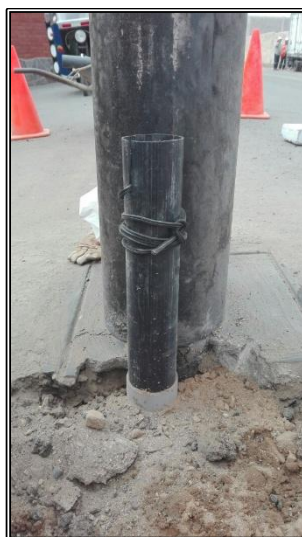
Figura N° 3.15 Instalación del sifón Fuente: Elaboración Propia
