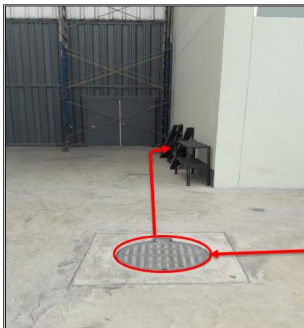
Figura N° 3.24 "Fibra óptica sigue recorrido por canalizado" Fuente: Elaboración propia.
