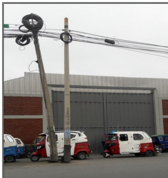
Figura N° 3.13 Poste y manga instalada Fuente: Elaboración propia
