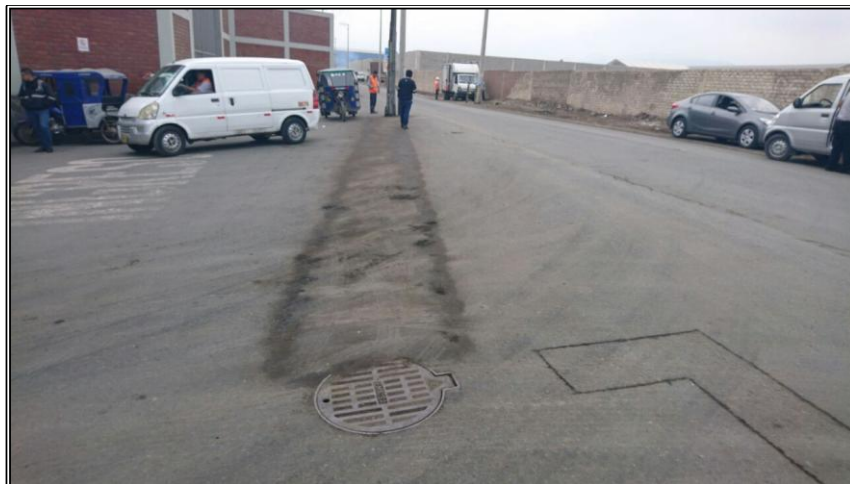
Figura N° 3.17 "Culminación del canalizado" Fuente: Elaboración propia.
