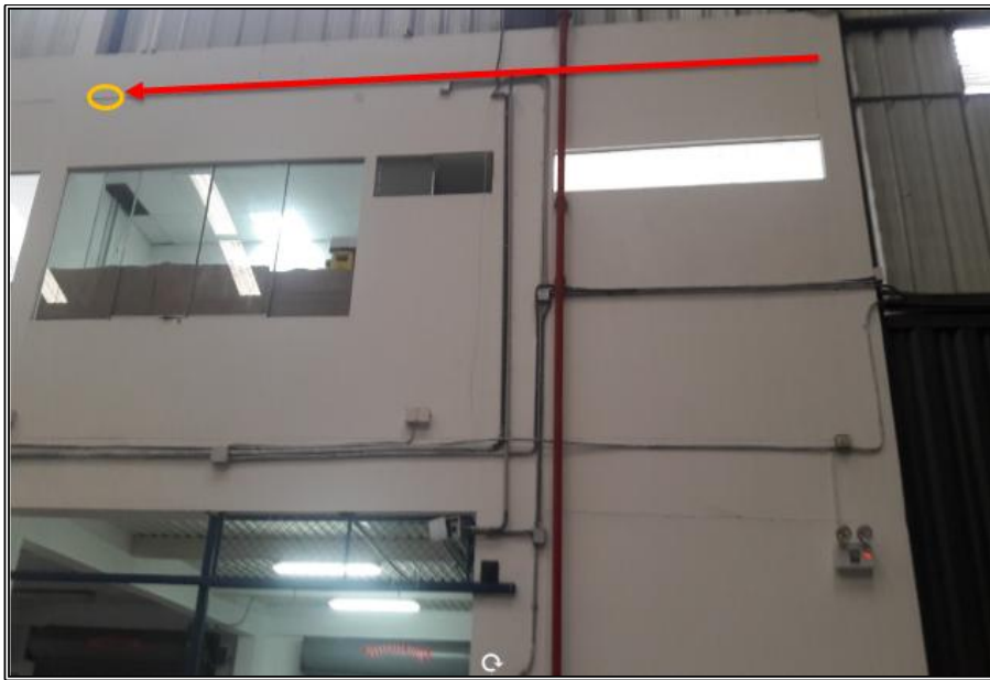
Figura N° 3.27 “Fibra óptica ingresa por perforado proyectado” Fuente: Elaboración propia.
