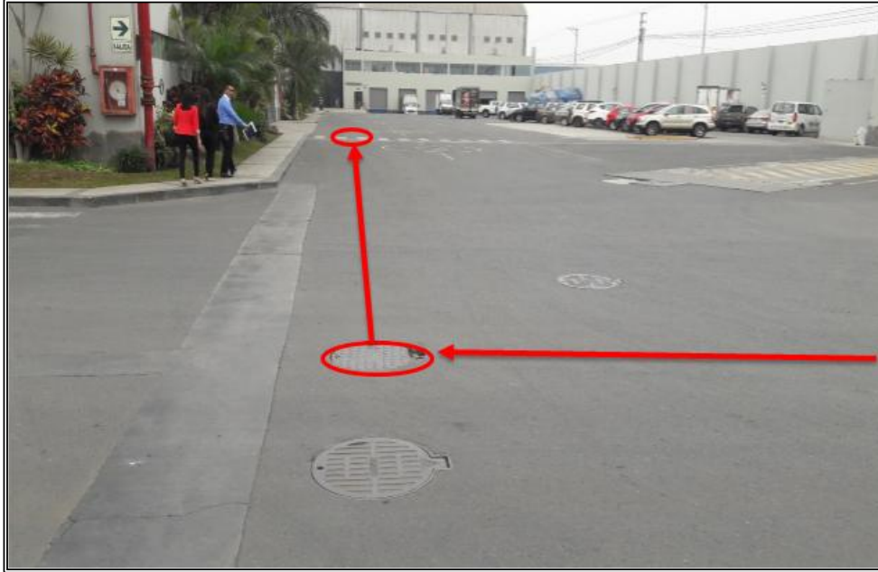
Figura N° 3.21 "Fibra óptica recorre por buzón y ductos existente" Fuente: Elaboración propia.
