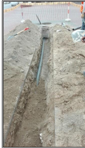
Figura N° 3.16 "Instalación del tubo de 3 pulgadas" Fuente: Elaboración propia.
