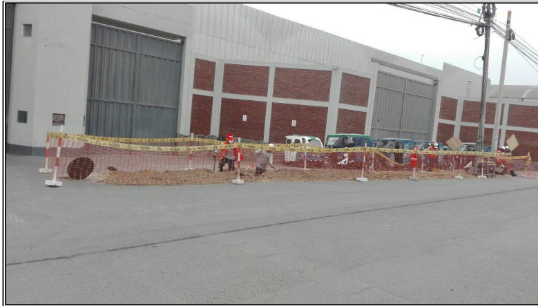
Figura N° 3.14 Inicio de Canalizado Fuente: Elaboración propia
