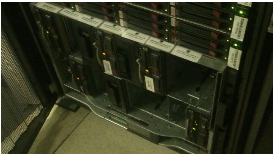
Figura 28. Instalación de servidores. Fuente: Área de Infraestructura GMD.
