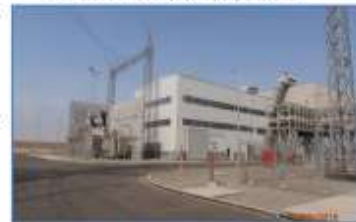
Nave de Turbina-Generador a Vapor
