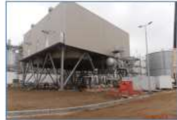
Vista del Aerocondensador
