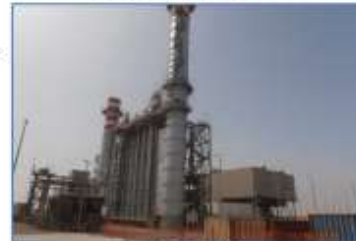
Vista de la C.T. Chilca 2
