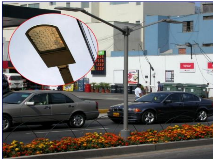
Figura 2 Alumbrado LED de la Av. General Pezet, Distrito San Isidro.
