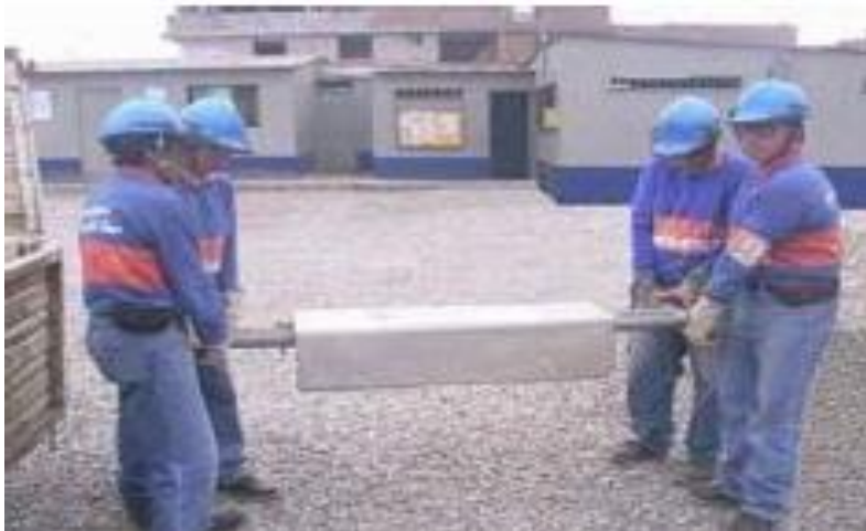
Figura 22 Traslado de ductos.
