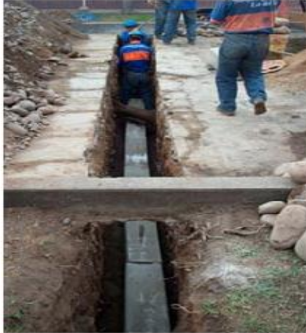
Figura 23 Instalación de ductos de concreto.
