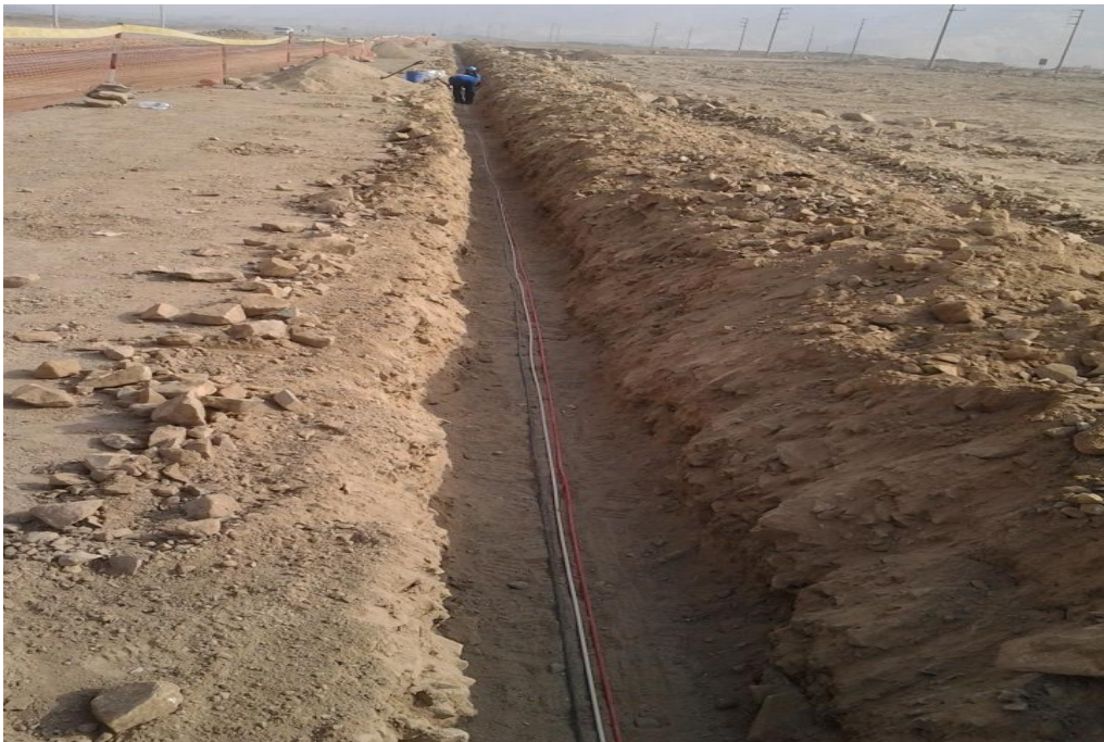
Figura 25 Tendido de cable.
