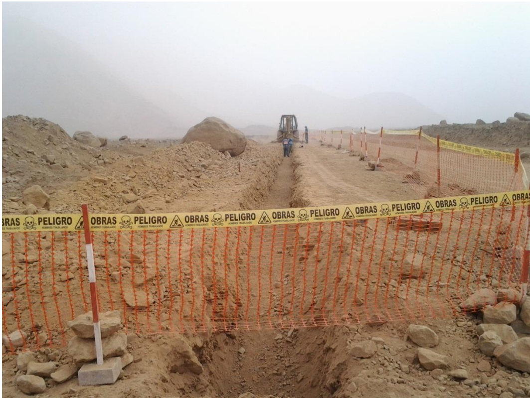
Figura 19 Excavaciones en obra.
