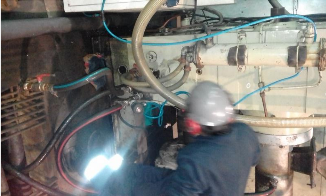
Personal técnico realizando inspección rutinaria
