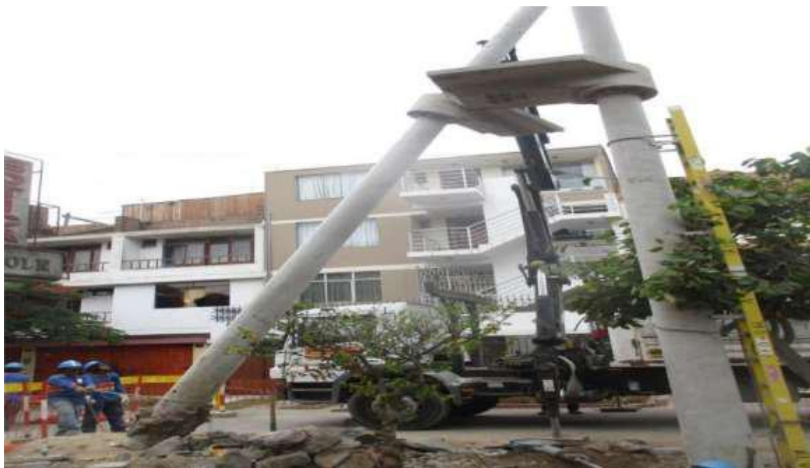
Figura 13: Instalación de postes de concreto
