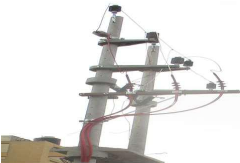
Figura 17: Ejecución de terminales exteriores Nota: elaboración propia.
