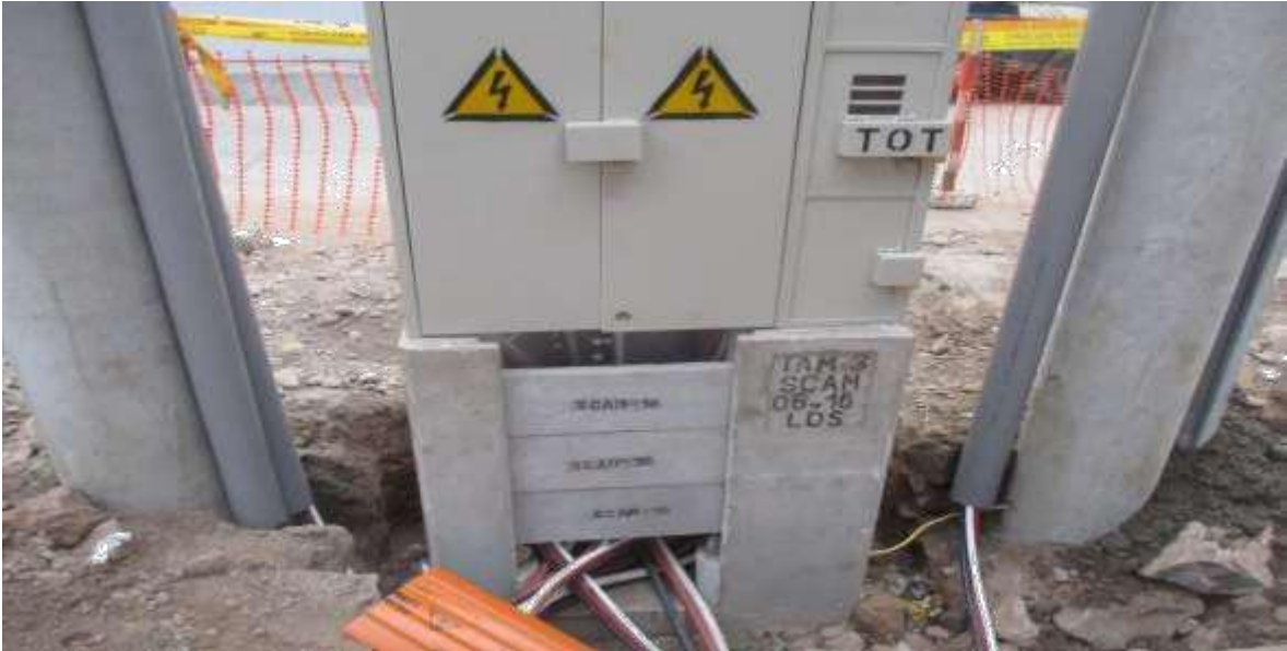
Figura 15: Instalación de tablero TAM 4 Nota: elaboración propia.
