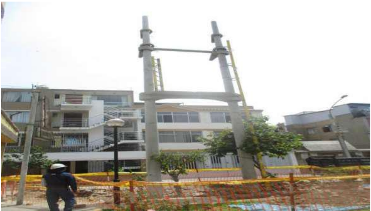
Figura 14: Instalación de plataforma y palomilla
