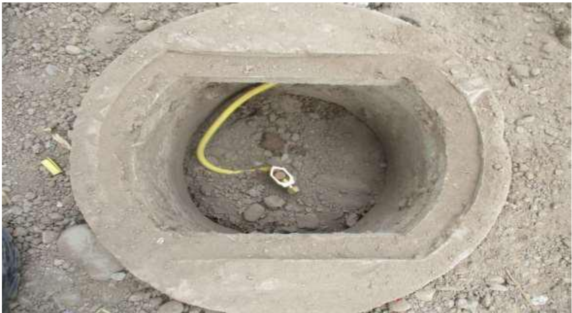
Figura 12: Ejecución de puesta a tierra Nota: elaboración propia.
