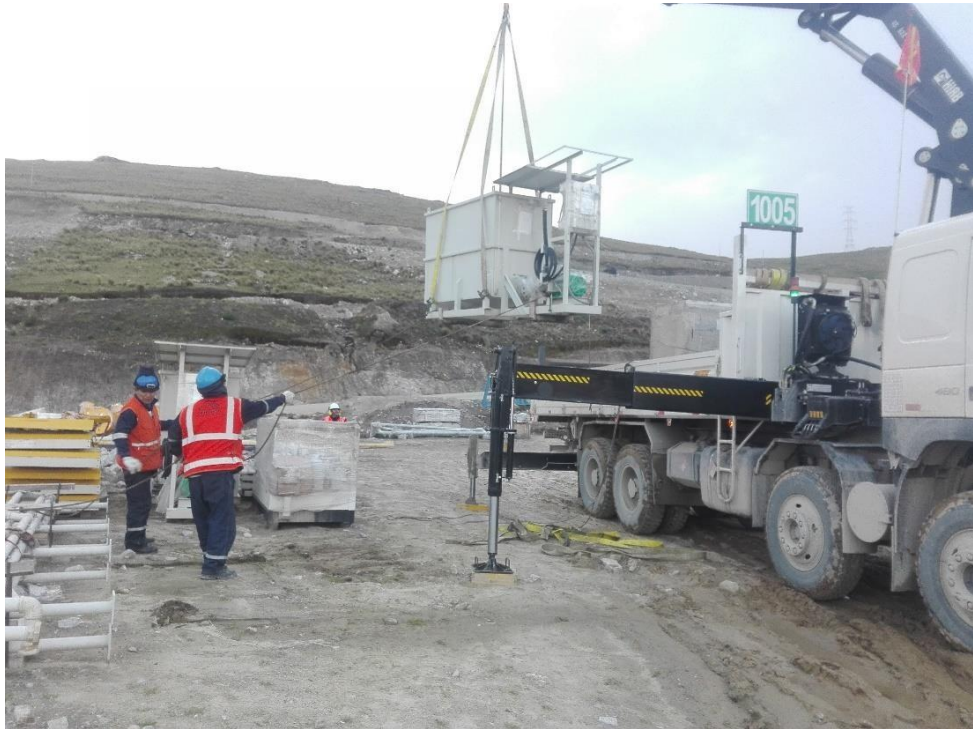
FIGURA N° 43: MONTAJE DE MODULO DE FUERZA
