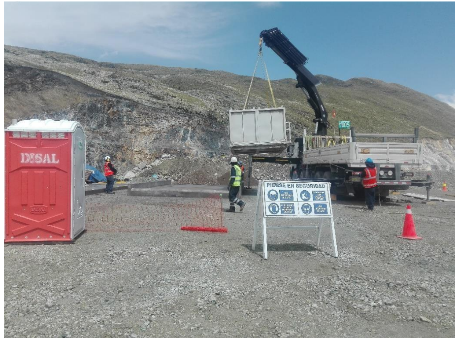
FIGURA N° 42: MONTAJE DE ESTRUCTURA DE LAVADERO
